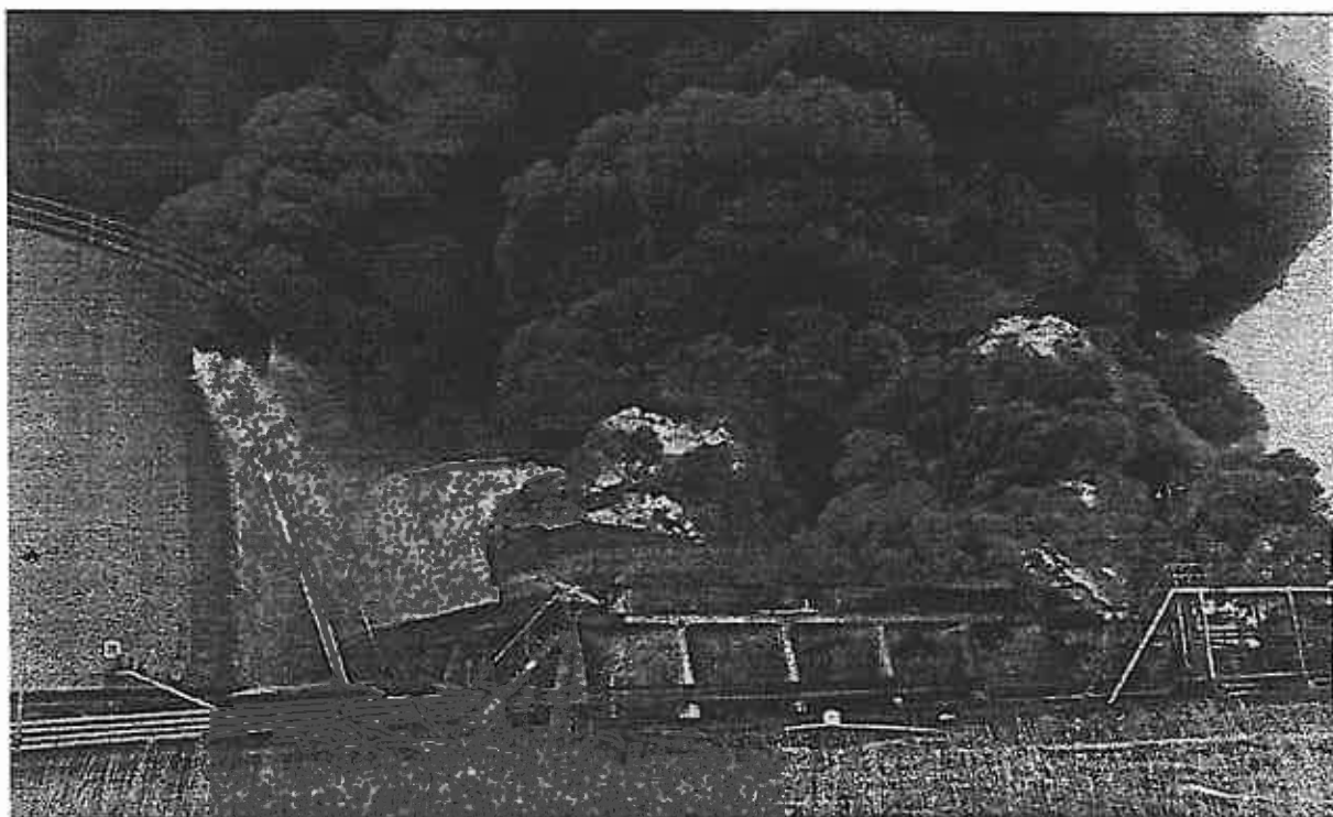
Kuva 4.24. Kokkolan säiliöaluepalossa säiliö 341( keskellä) sekä säiliöt 344, 343 ja 342 (oikealla) ovat liekeissä, mutta säiliöstä 407 (vasemmalla) ja 340 (vesisuihkuista oikealle) polttoaine haihtui ja valui säiliön syttymättä, (K. Ölander 1973, kuva K. Laakso).
