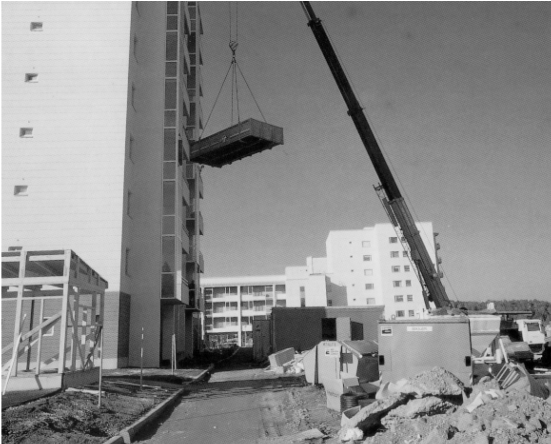
Kuva 5.6. Vaihtolavan käyttö jätteiden keräilyyn parvekkeilta [16].
