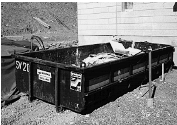
Kuva 5.5. Sekajätevaihtolava on varustettu nostokorvilla, jolloin sitä voidaan siirtää työmaan nosturilla tarpeen mukaan.
