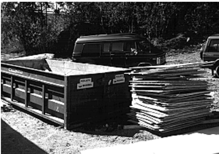
Kuva 5.13. Vaihtolava puujätteelle Skanskan työmaalla.
