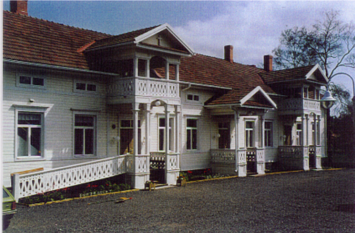
Kuva 1. Vanha perinteinen puutalo. Toimivassa rakennuksessa on hyvin tuulettuva, korkea perustus ja harjakatto, jossa on kunnolliset räystäät.
