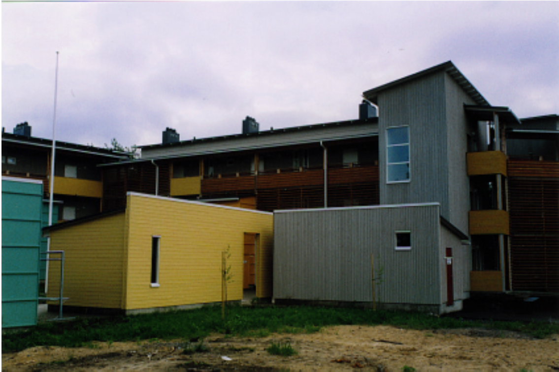
Kuva 6. Puurakentaminen on saavuttamassa maassamme uuden tason kerrostalorakentamisen myötä. Yhdistämällä teoreettinen tietämys kokemustietoon ja muualta saatavaan käyttökokemukseen ollaan koe- ja mallirakentamisen kautta tuottamassa toimivia ja pitkäkestoisia puurakennuksia.
