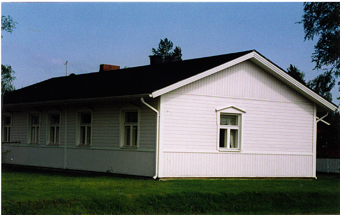
Kuva 4. Uusi puutalo 1990-luvun alusta. Rakennuksessa on edelleen havaittavissa monia entisen kaltaisia riskitekijöitä, jotka on voitava jatkossa poistaa (matalat perustukset).
