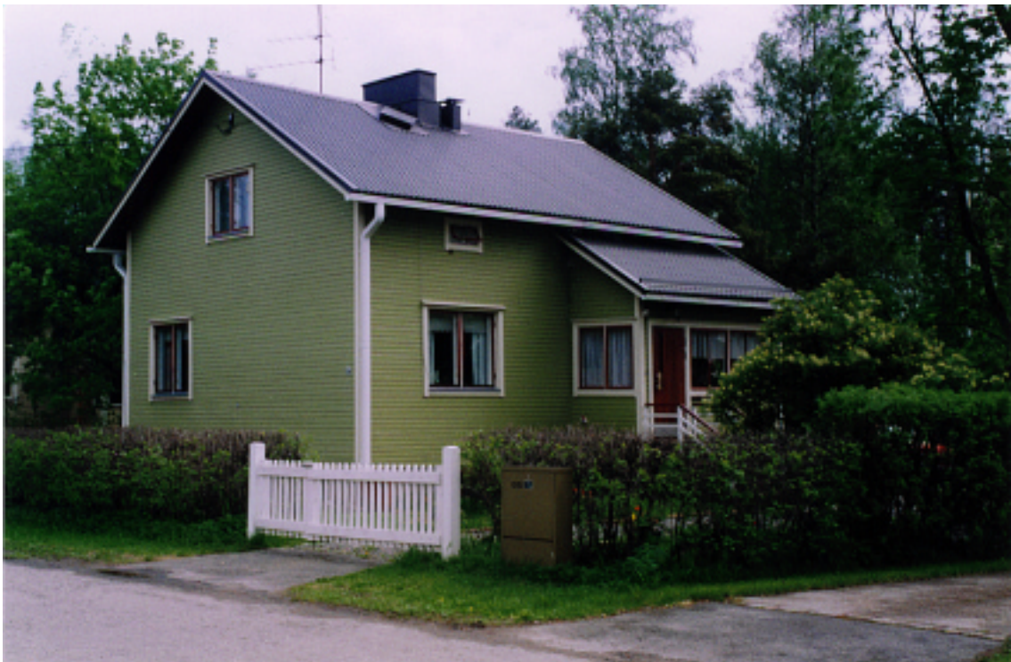
Kuva 2. Rintamamiestalo. 1 ½-kerroksinen monikäyttöinen rakennus, joiden toimivuus on ollut varsin hyvä.
