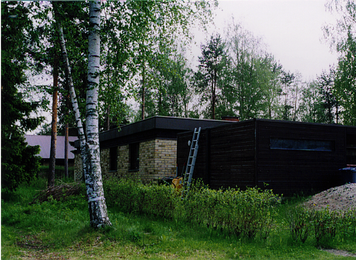
Kuva 5. Loivat katot ovat aiheuttaneet paljon ongelmia. Kunnollinen harjakatto on luotettava ratkaisu, joskin katemateriaalien paranemisen myötä myöskin loivat katot voidaan tehdä ja korjata varsin luotettavaksi.
