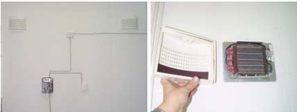
Kuva 5. Ilmanvaihtokoneen ulkoilma- ja jäteilmakanavat johdettiin seinästä ulos. Ilmanvaihtokone oli toiminnoiltaan ja rakenteeltaan laitetoimittajan vakiomalli.
