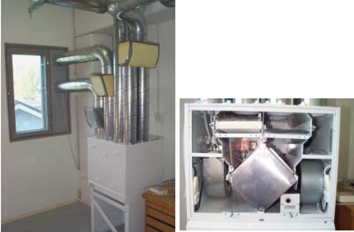
Kuva 5. Ilmanvaihtokoneen ulkoilma- ja jäteilmakanavat johdettiin seinästä ulos. Ilmanvaihtokone oli toiminnoiltaan ja rakenteeltaan laitetoimittajan vakiomalli.
