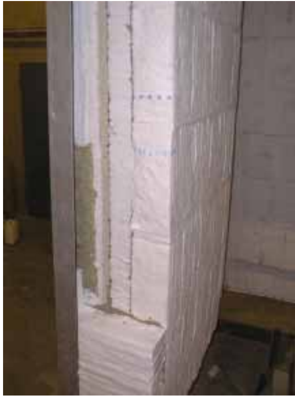
Kuva 10. Liimarakenteita vasemmassa seinässä.
