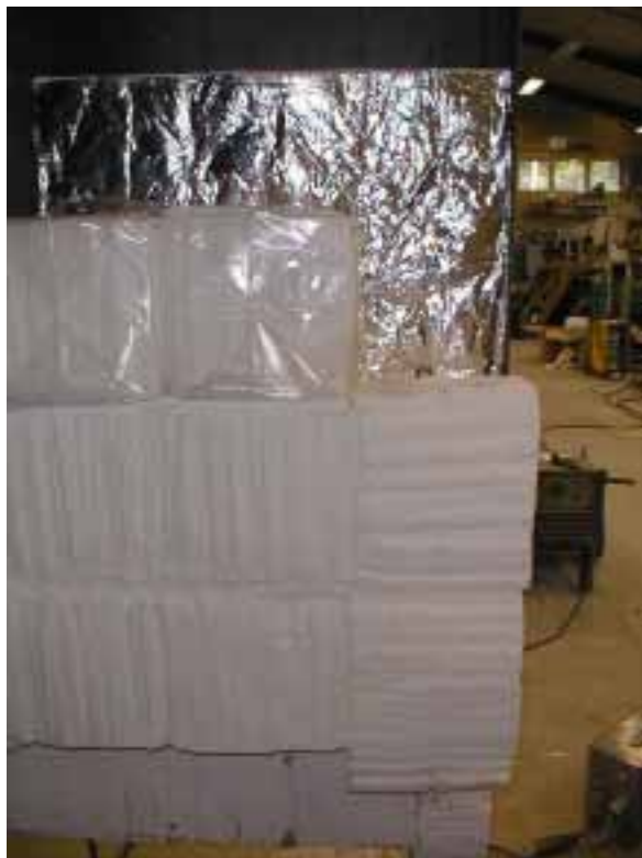
Kuva 4. Prismobloc-seinää rakennusvaiheessa.
