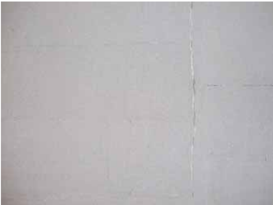
Kuva 5. Vasemman seinän keskiosan liimattua rakennetta noin viikon katkonaisen koeajojakson jälkeen. Kuvassa on havaittavissa pystysuora särö sekä joitakin vaakasuoria.
