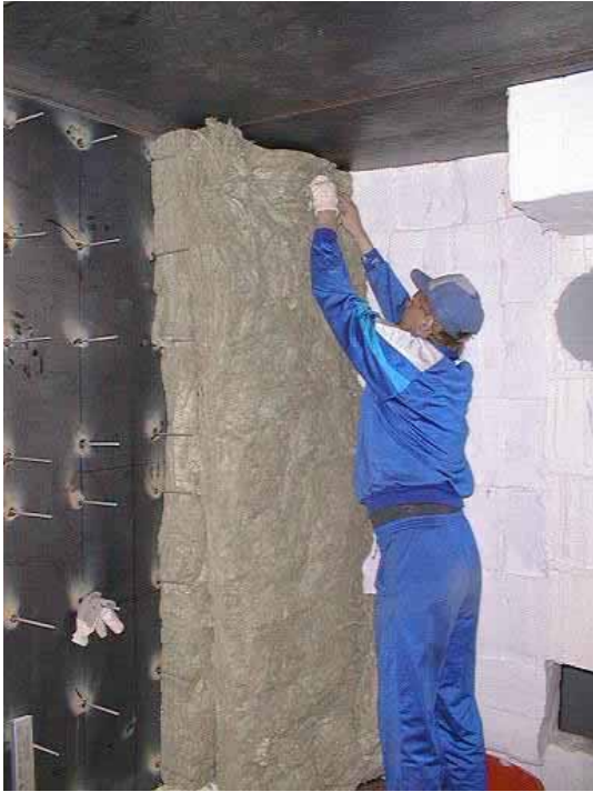
Kuva 7. Taustaeristeen asennusta.
