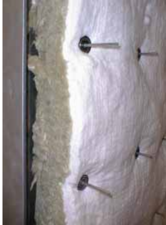
Kuva 8. Eristekerroksia taustaeristeessä.
