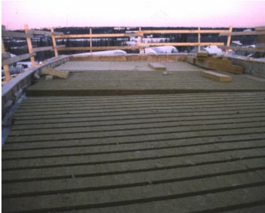
Kuva 21. Rovakate Oy:n toimitalon uritettujen lämmöneristeiden asennustyöt.
