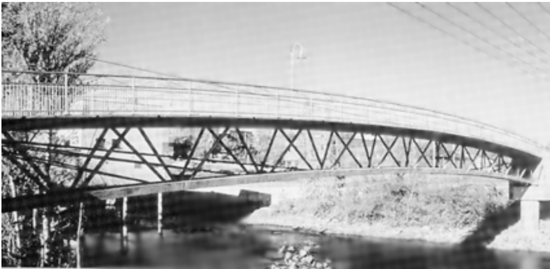
Kuva 4. Sherbrooken RPC-kävelysilta Kanadassa /1/.
