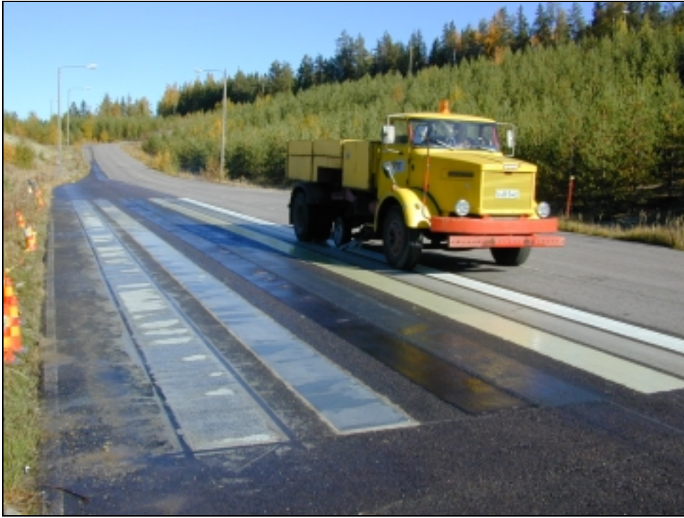
Kuva 2. VTT:n kitkamittausauto ja koerakennettä Vihdissä.
