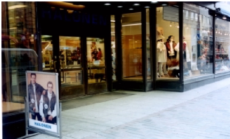
Kuva 4.2. Helsingin keskustan rakennusten sisäänkäyntien esteettömyystarkastelussa kriteereiksi valittiin kynnyksen korkeus, oven ja portaiden sijainti seinälinjaan nähden sekä luiskan ominaisuudet [Esteetön katu ympäristö 2000]. Viiden tähden sisäänkäynnissä on matala kynnyks ja ovi reilusti seinälinjan sisäpuolella, joten luiskaa ei tarvita. (Helsinki, Aleksanterinkatu)
