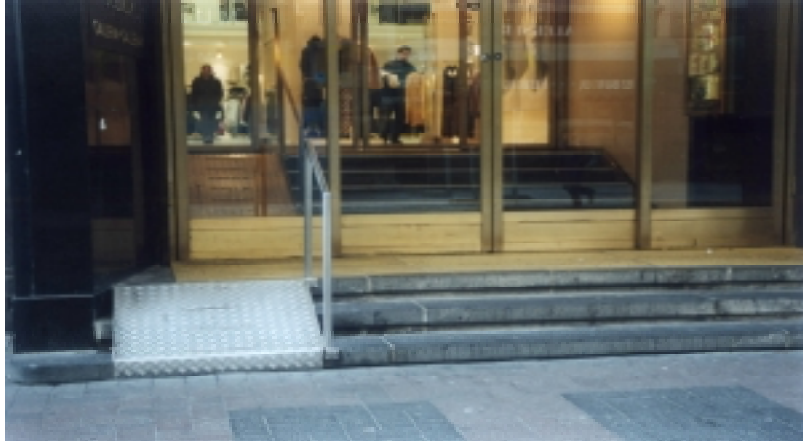
Kuva 4.3. Kolmen tähden ”minimitoimivassa” sisäänkäynnissä on paljon portaita, mutta tilannetta parantvat melko jyrkkä kaiteellinen ramppi sekä sisäänkäynnin suojaisuus rakennusmassan sisässä. Ongelmia aiheuttaa portaiden ulottuminen katualueelle. (Helsinki, Aleksanterinkatu)
