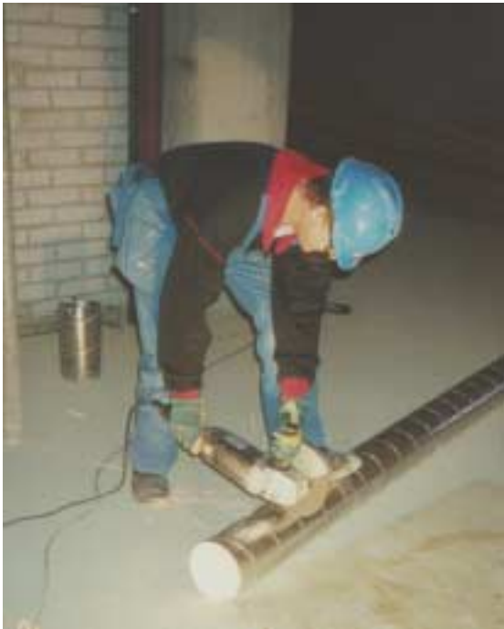
Kuva 5. Kanavan katkaisu kulmahiomakoneella.
