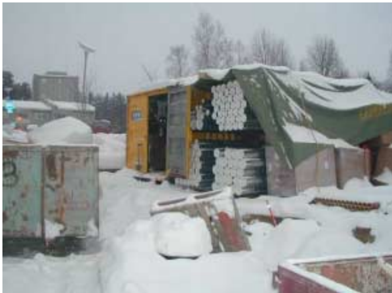
Kuva 14a. Kanavien varastointi työmaalla. Kanavanojat ovat varastossa kontissa.
