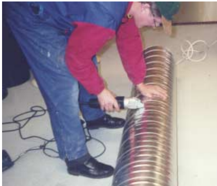
Kuva 10. Kanavan katkaisu Dräcon levyleikkurilla.
