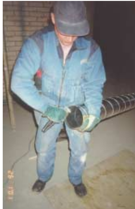
Kuva 6. Kanavan sisä- ja ulkopuolisen jäysteen poistaminen pop-niittipihdeillä.
