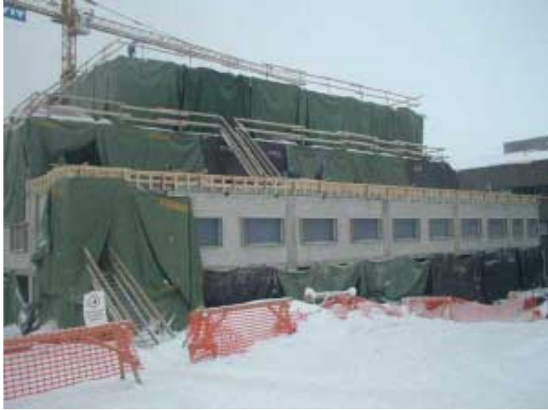
Kuva 13. Yliopistollisen sairaalan laajennustyömaa.
