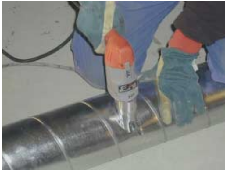
Kuva 12. Milwaukeeen sähkökäyttöisillä peltisaksilla leikatessa kanavan ulkopuolelle syntyy ohut metallinauha.
