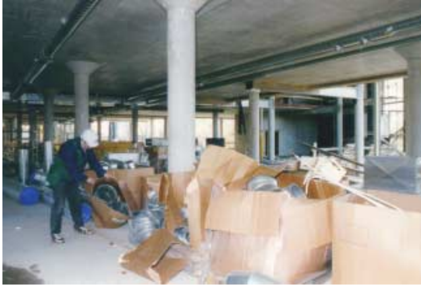
Kuva 3. Kanavanosien varastointi työmaalla pahvilaatikoissa kohteessa 2.
