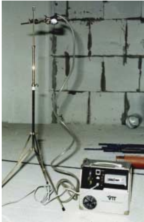
Kuva 4. Ilman pölypitoisuuden mittaus työmaalla.
