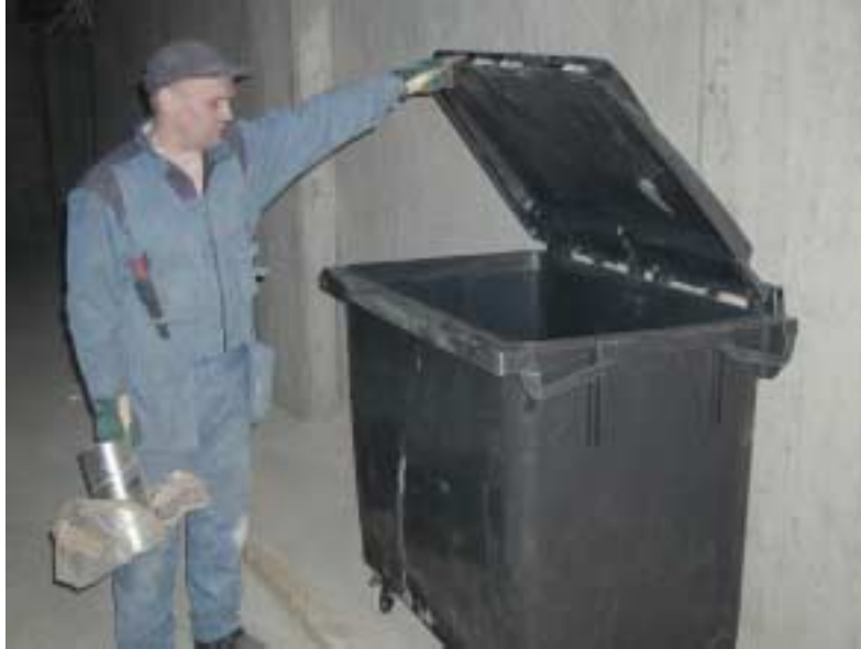
Kuva 14b. Kanavanosien varastointi työmaalla liikuteltavassa roskalaatikossa.
