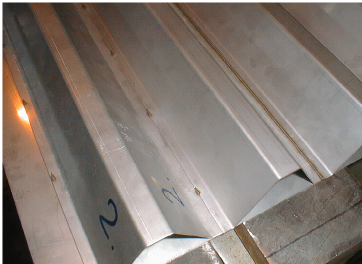
Kuva 13. Ruostumattomasta teräksestä valmistettu kerroslevy ennen toisen pintalevyn asennusta.
