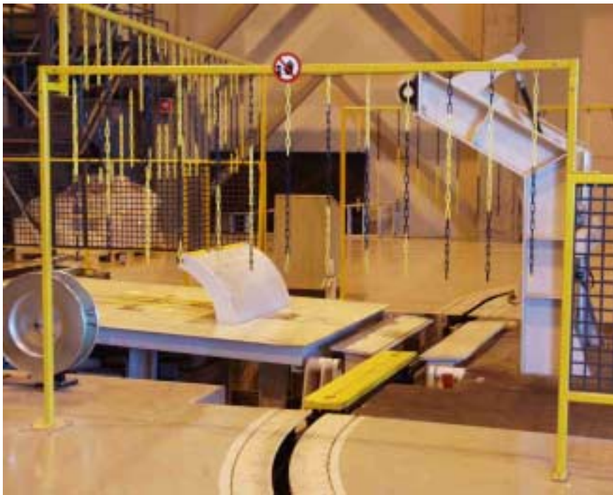
Kuva 20. Käyttäjiä varoittavia kulkuaukkoihin ripustettuja ketjuja.
