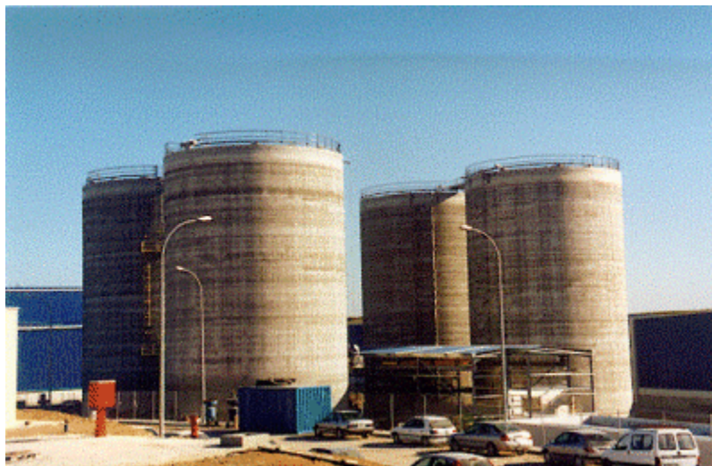
Kuva 26. Cadizin laitos Espanjassa, käsittelee 115 000 t MSW/a, viipymäaika vähintään 25 vuorokautta, tuottaa lämpöä ja sähköä. (Babcock Borsig Power-Austrian Energy 2001)
