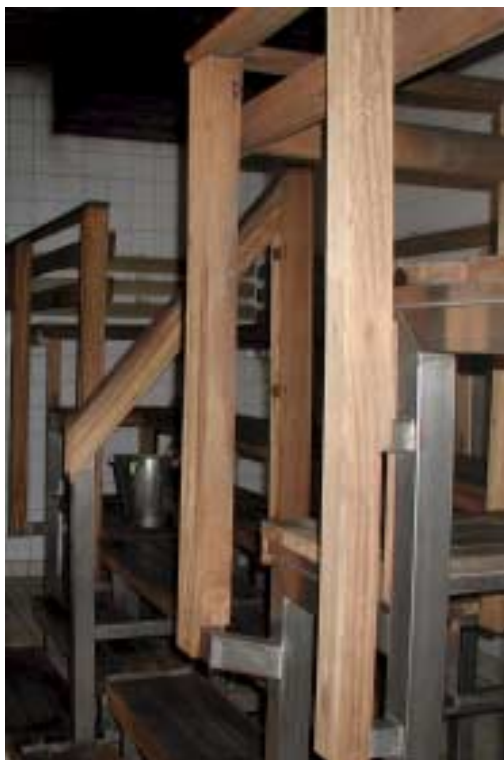
Kuva 5. Saunan lauteiden alapintojen siivous voi olla joissakin tapauksissa hankalaa.
