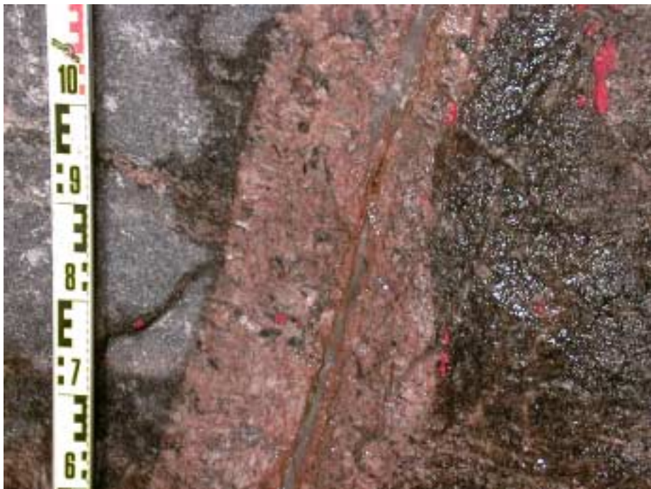
Kuva 38. Pohjoistunnelissa havaittavan pystyasentoisien punertavan graniittipegmattijuoenen keskellä sijaitsevaan kvartsitäytteeseen hiertosaumaan liittyy vettä vuotava (0.5–1 l/min) halkeama.
