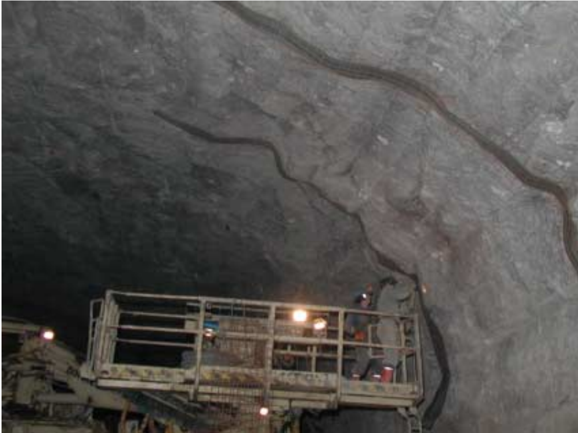
Kuva 34. Salaojien asennusta Viikinmäen jäteveden puhdistamon suodatushallissa.
