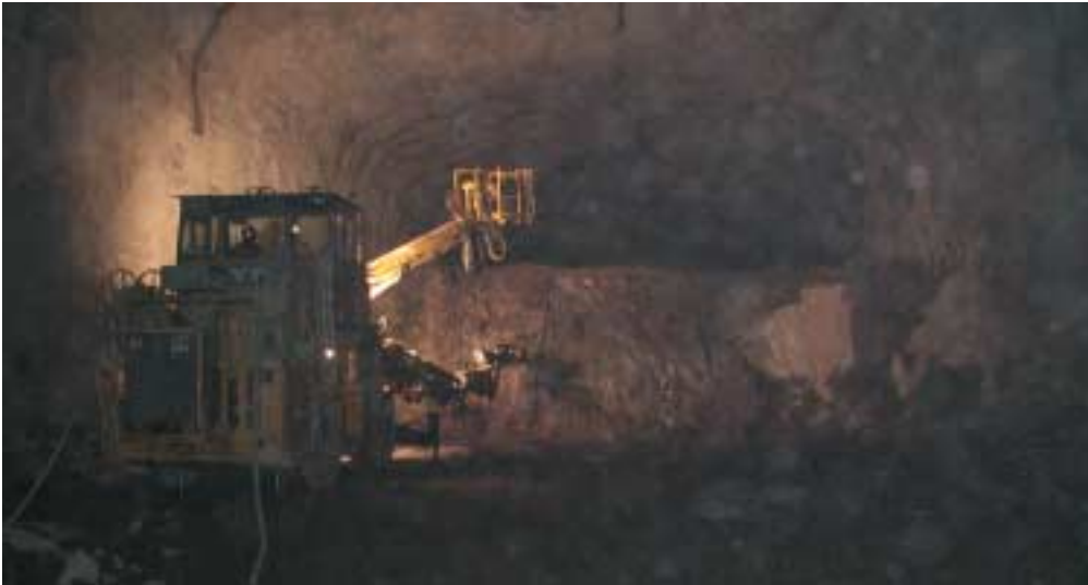
Kuva 32. Nostolouhinta käynnissä Viikinmäen halli 9:ssä; holviprofiilissa havaittavissa piston aiheuttamaa porrastusta sekä seinälle päättyvä salaoja.
