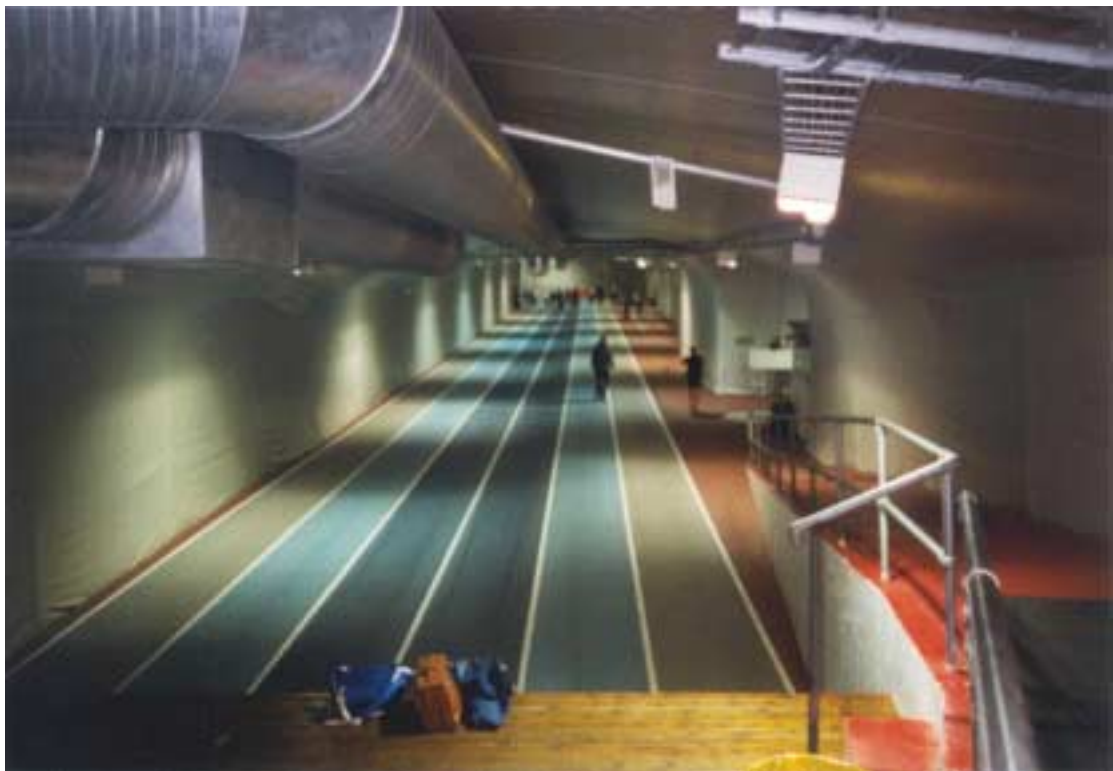
Kuva 9. Bergenissä, Høyehallen urheiluhallissa toteutettu PVC-kangaseriste. Pieni ilmankuivain riittää pitämään suhteellisen ilmankosteuden haluttuna.
