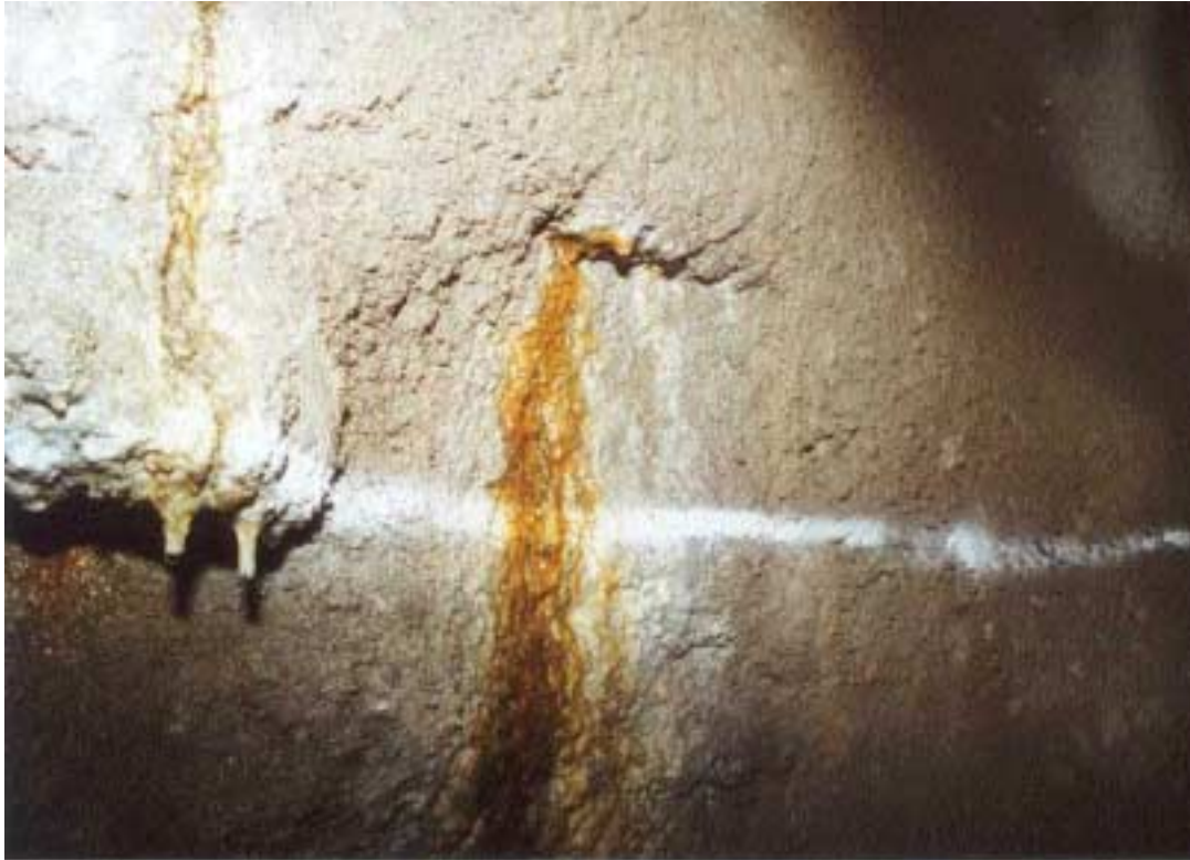
Kuva 3. Tyypillinen vuoto epätasaisella kalliopinnalla. Vesi tulee 'kielekkeen' alta.
