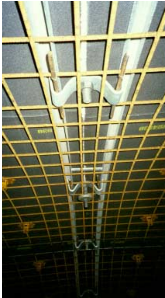
Kuva 11. Ekeberghvelvet kiinnitysmekanismi asennettuna .
