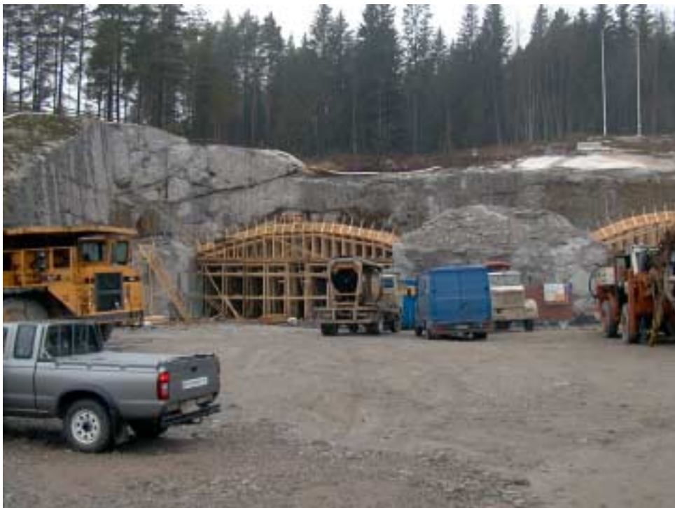
Kuva 33. Isonkylän moottoritietunneleiden itäpään suuaukkojen betonivalumuottien rakentaminen käynnissä.
