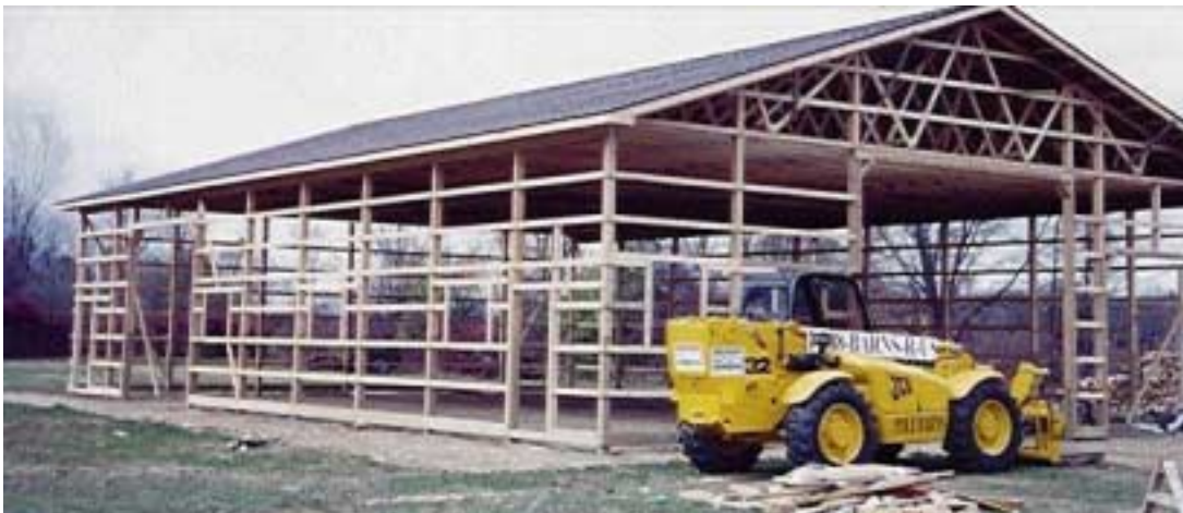
Kuva 23. Post-Frame-rakentamista Yhdysvalloissa.
