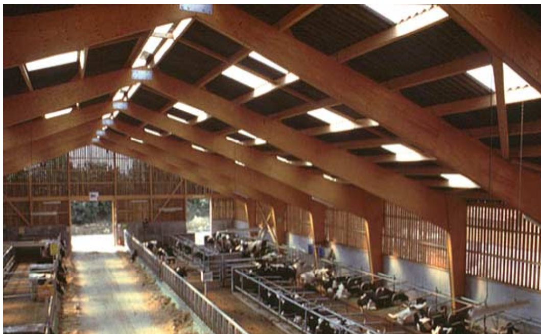
Kuva 28. Esimerkki saksalaisesta lypsykarjapihatosta, jossa on kantavana rakenteena kolminivelkehä.
