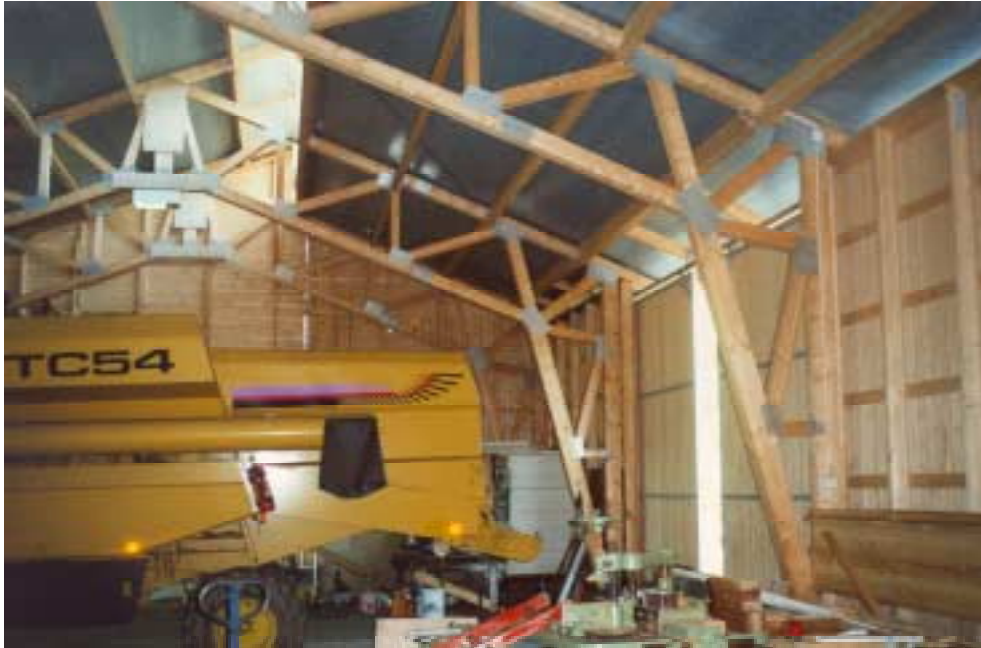
Kuva 21. Valmis NR-kehähalli.
