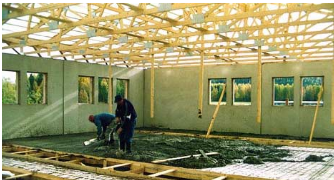
Kuva 1. Tyypillinen sikalatyömaa. Sikalan kantavat seinät ovat betonielementtejä ja kattorakenteet naulalevyristikkoja.
