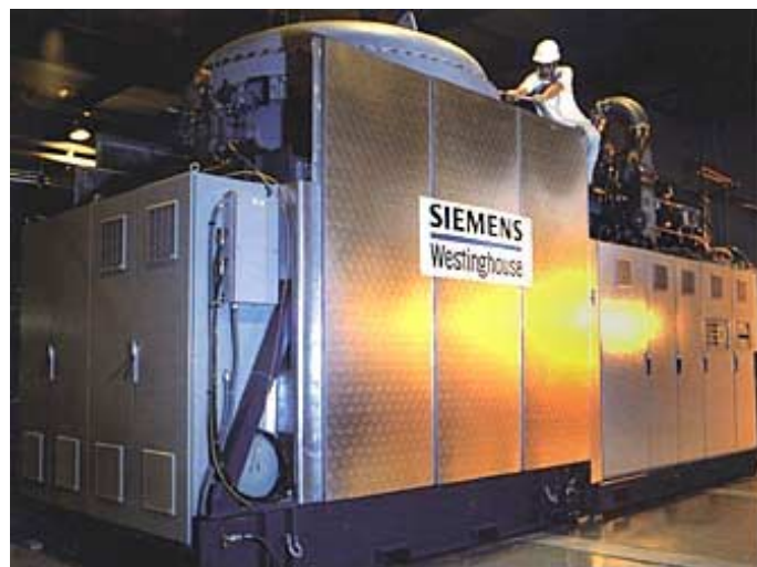
Kuva 71. Siemens Westinghousen 220 kW sähköntuotantoyksikkö oli maailmassa ensimmäinen järjestelmä, jossa on yhdistetty mikroturbiini ja kiinteäoksidipolttokenno. [69]
