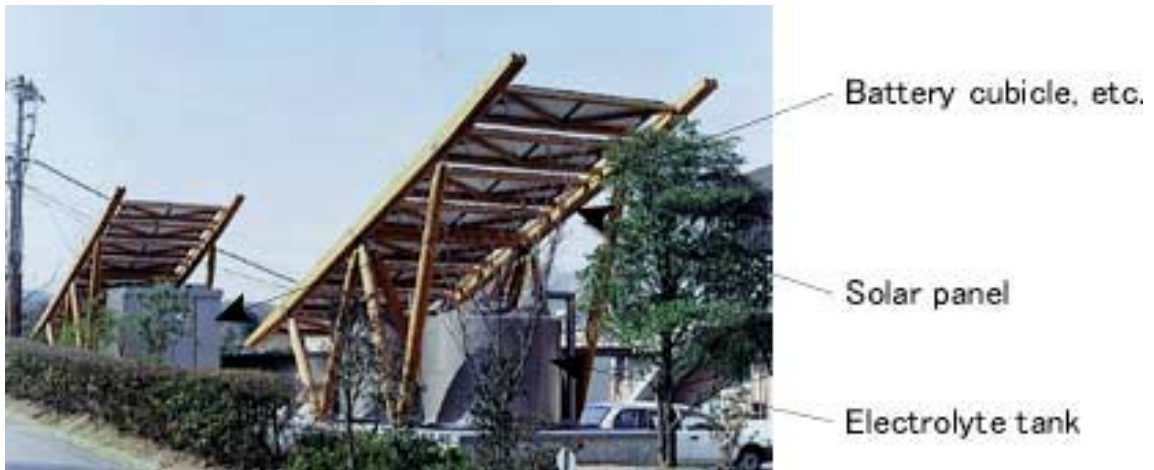
Kuva 84. SEI:n redoksivirtausakut aurinkovoimalan tuotannon tasauksessa. [62]
