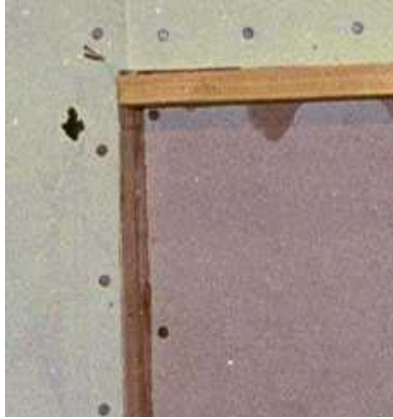
Kuva 13. Kankaan kiinnitys. Kuva esittää aluetta, jonka koko on 300 \times 300 \text{ mm}^2 .
