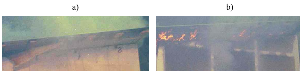
Kuva 22. Savukaasujen vuotaminen ulos osastoivan seinän ja vesikaton liittymästä: a) hetkellä 8:50 ja b) noin 21 minuuttia kokeen alkamisen jälkeen.
