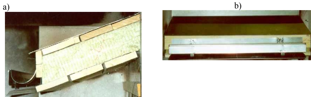
Kuva A27. a) Räystäs oikealta sivulta ja b) edestä.
