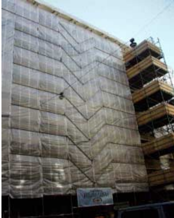
Kuva 18. Julkisivukorjauksen suojaus vahvistetuilla kevytpeitteillä. Huomioi nostoihin tarkoitettu torni. (Kuva: Telinekataja Oy.)
