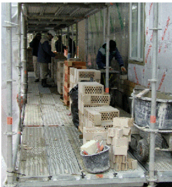
Kuva 9. Julkisivun muuraustyöhön käytettävä teline sekä kuvan mukaisen telineen periaatepiirros. Piirtänyt: Jyrki Furuholm, Telinekataja Oy.
