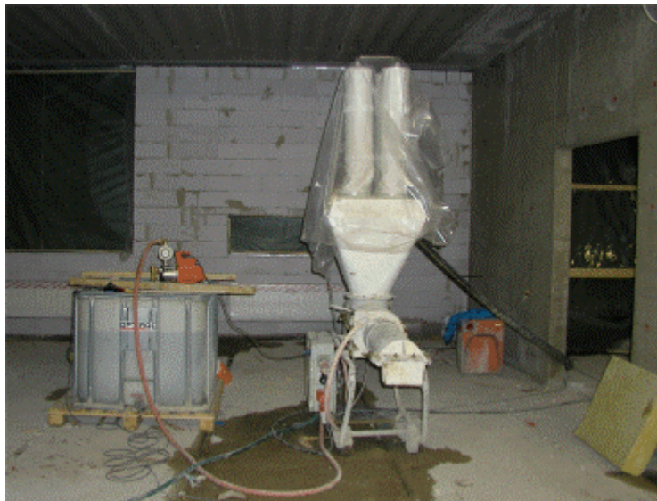
Kuva 26. Laastisekoitin ja lämmitettävä vesi suojatussa sisätilassa.
