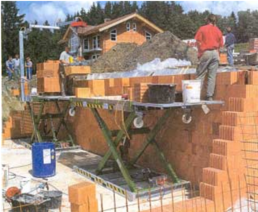
Kuva 11. Portaattomasti säädettävä työlava saksalaisella työmaalla (Schlötzer 2002).
