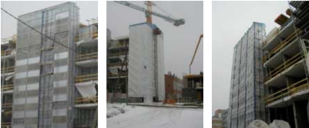
Kuva 30. Työtilan sääsuojaus pilottikohteessa.
