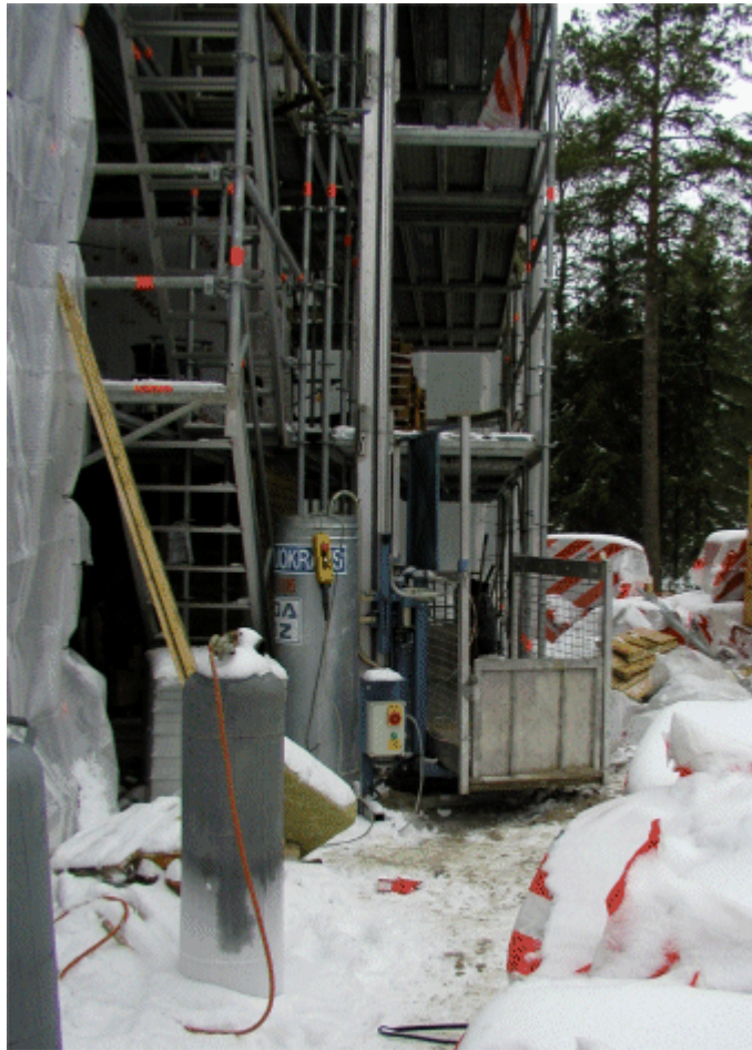
Kuva 12. Telinejärjestelmään liitetty tavarahissi tiilien ja muurauslaastin nostoihin.
