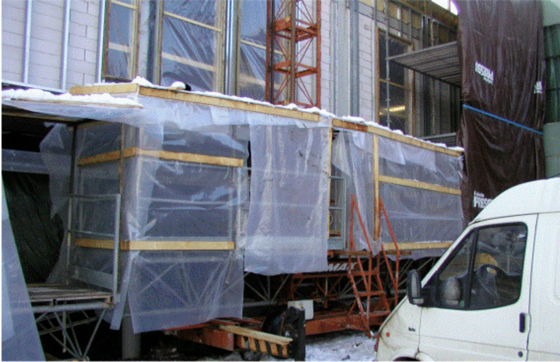
Kuva 10. Rakennusmuovilla suojattu mastolava. Huomaa, että vanhoissa malleissa taso ei laskeudu alas saakka, jolloin materiaalin siirtoihin työtelineelle on aina käytettävä muita nostolaitteita.
