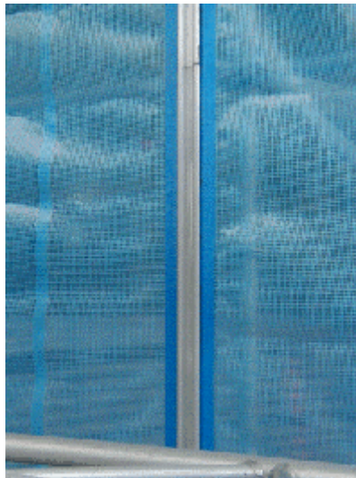
Kuva 17. Telineisiin yhdistettävään alumiinikiskoon kiinnitetty suojapeite. Peitteessä on reunapunokset, joiden avulla peite vedetään kiskossa oleviin uriin.
