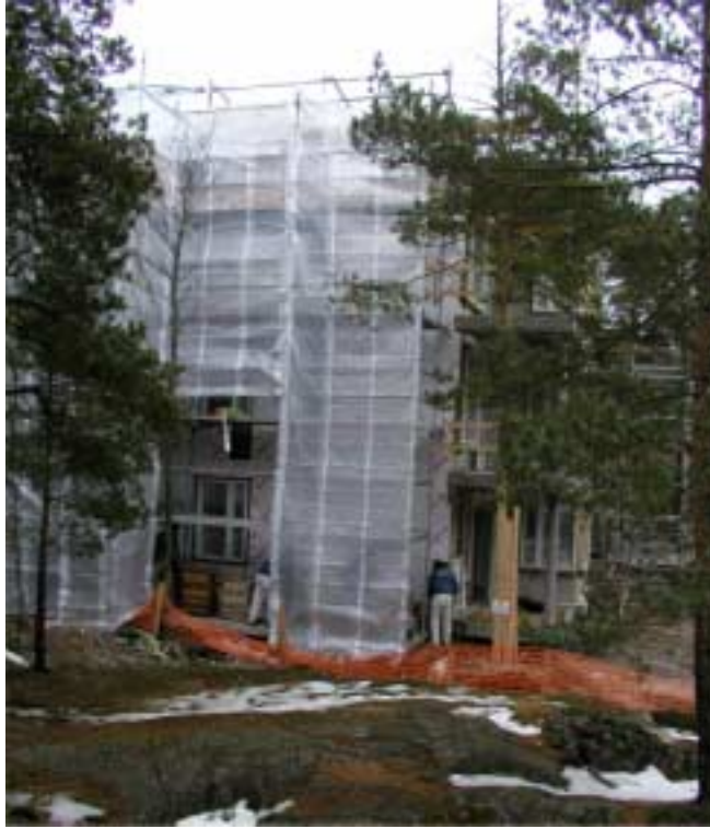
Kuva 16. Vahvistetulla kevytpeitteellä suojattu muurattava julkisivu.
