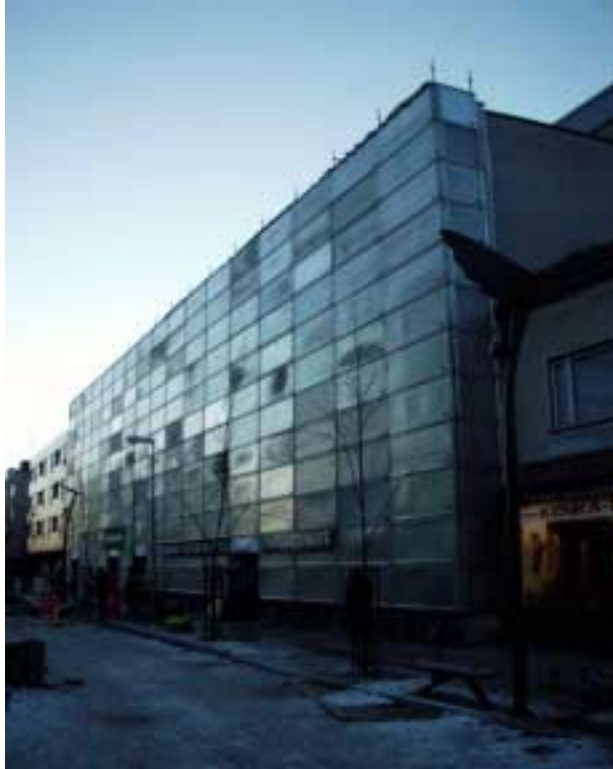
Kuva 19. Alumiiniprofilikaseteilla suojattu julkisivu. Saatavana myös valoa läpäiseviä kasetteja. (Kuva: Telinekataja Oy.)
