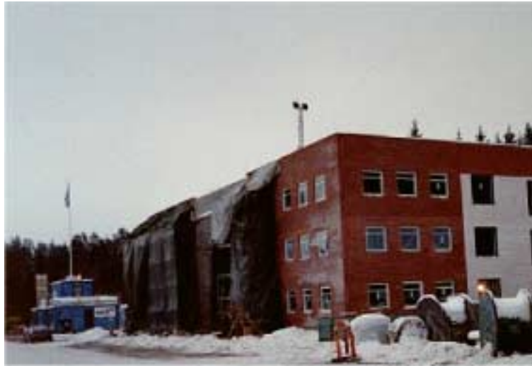
Kuva 14. Rakennuspeitteillä suojattu julkisivumuurausteline.
