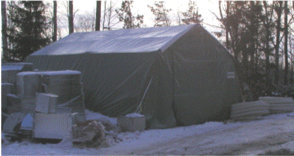
Kuva 22. Tiilien varastoinnissa käytetty umpinainen suoja.
