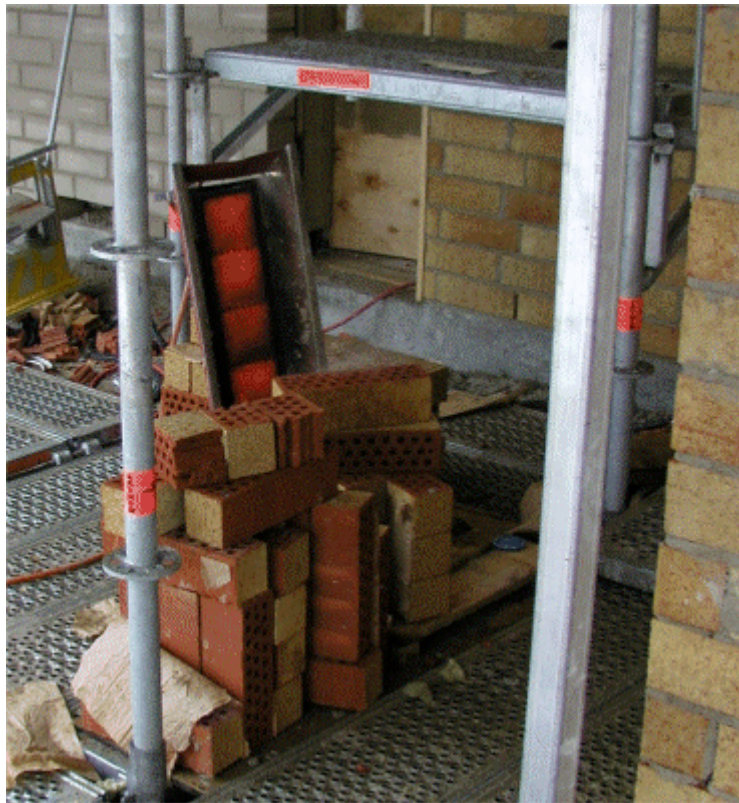
Kuva 23. Tiilien ja muuratun rakenteen lämmitys työkohteessa infrapunalämmittimellä.
