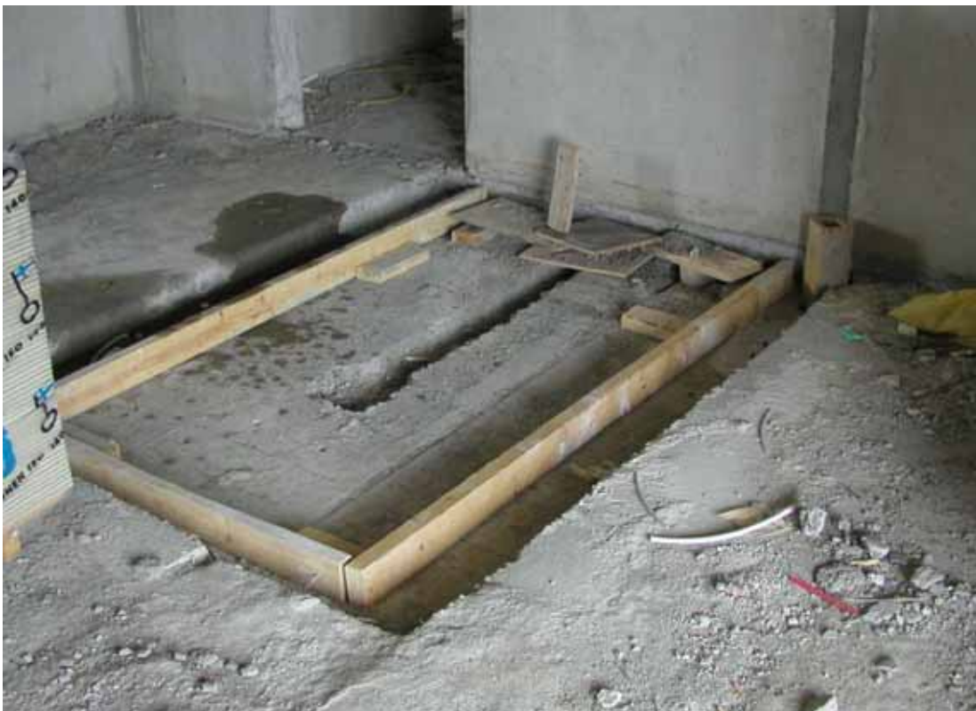
Kuva 22. Rungon sisällä tehtävät jälkivalut ovat raskaita ja vaikeasti organisoitavia sekä turhia tehtäviä prosessissa.
