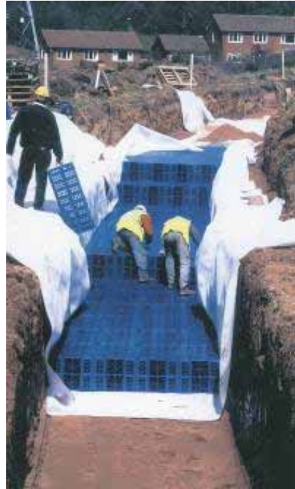
Kuva 24. Tulvehtimisriskin pienentämiseksi tulee kasvattaa hulevesiviemäreiden putkikokoa tai rakentaa viemäriverkoston välityskykyä tasaavia sadeveden varastointirakenteita.
