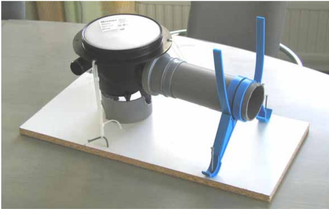
Kuva 9. Lattiakaivon ja viemärin mallikiinnitys nippusiteiden ja valutukien (Toimex Oy) avulla.
