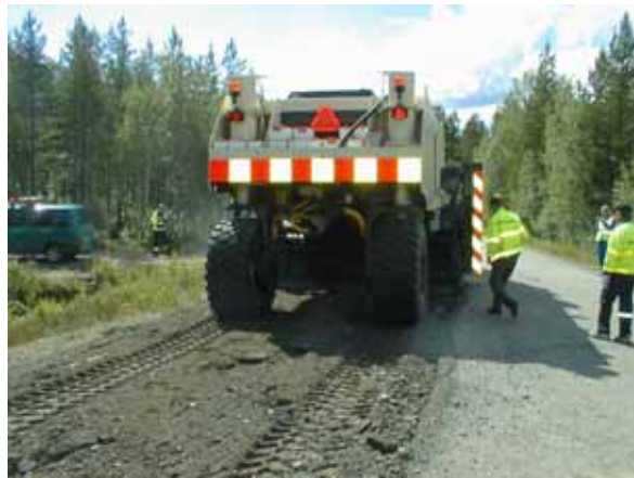
Kuva 4. Vanhan tienpohjan vahvistaminen stabilointijyrshintäjä (kuva VTT).
