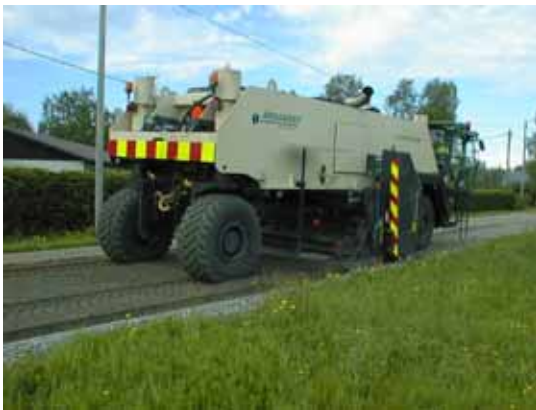
Kuva 32. Stabilointijyrsin ja ajoneuvo-pc:llä toteutettu käyttöliittymä (kuvat VTT).
