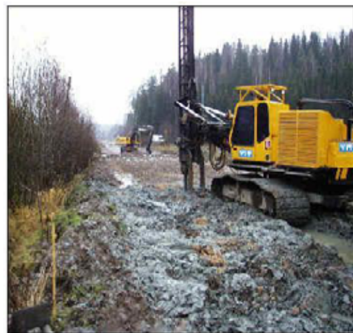
Kuva 5. Pohjanvahvistus lyöntipaalutuksella ja syvästabiloinnilla (kuvat Junttan Oy ja YIT Oy).
