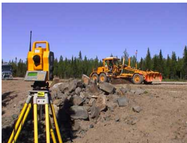
Kuva 1. Tiehöylän 3D-ohjausjärjestelmä Kemi–Tornio-moottoritietä työmaalla (kuva VTT).
