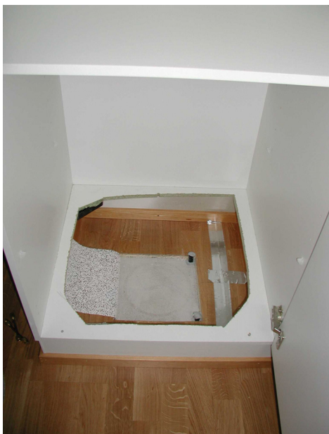
Kuvat 10 ja 11. Kaapiston alapuoliseen sokkelitilaan lattiarakenteen seurantamittauksia varten rakennettu, avattavissa oleva lattiapinnoite.
