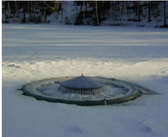
Kuva 6. Visiox-ilmastimen toimintaperiaate (kuvat: Vesi-Eko Oy).
