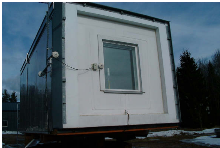
Kuva 10. Tuloilmaikkuna asennettuna PASLINK-testitilan julkisivuun.
