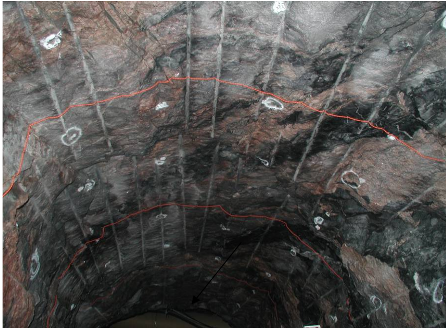
Kuva 9. Koealueiden kalliopintaan asennetut injektointiputket (punaiset) ennen ruiskubetonointia.
