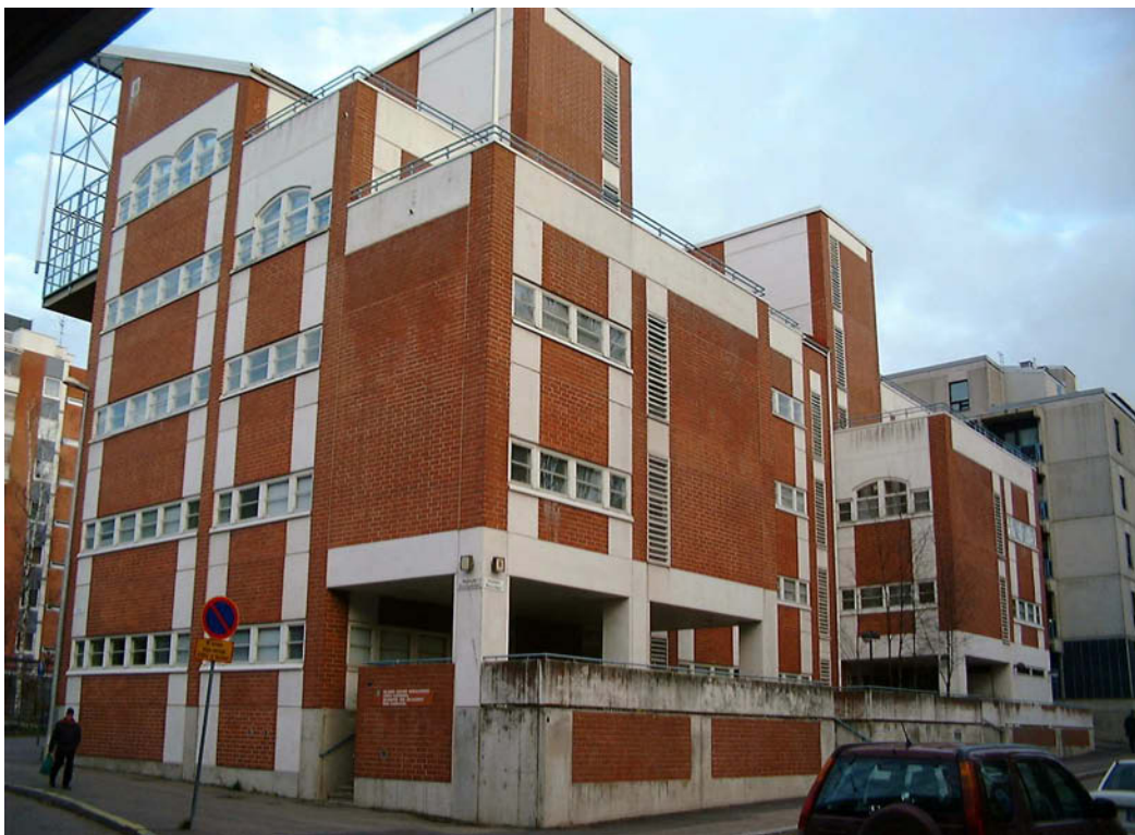
Kuva 16. Kohde 7, toimistorakennus vuodelta 1989.
