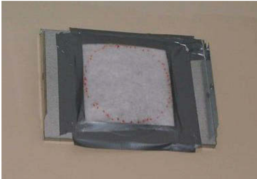
Kuva 23. Polypropeenisuodatinkangas kiinnitettynä tuloilmaelimen paikalle.
