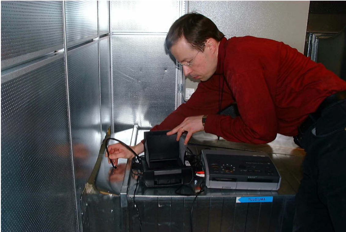
Kuva 17. Ilmanvaihtokoneen lamelliäänenvaimentimen kunnon tarkastus pienellä kanavakameralla kohteessa 9.
