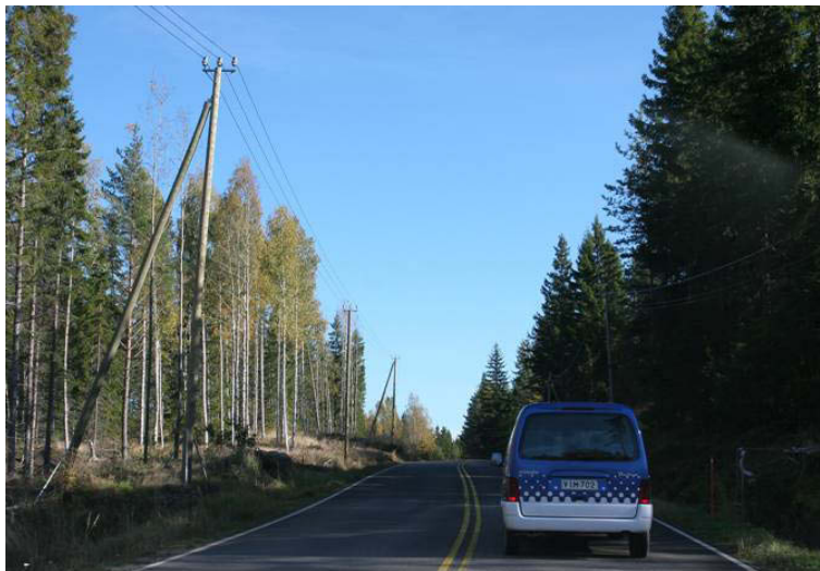
Kuva 5.5. PAS-tekniikalla toteutettu johto-osuus tien varressa.
