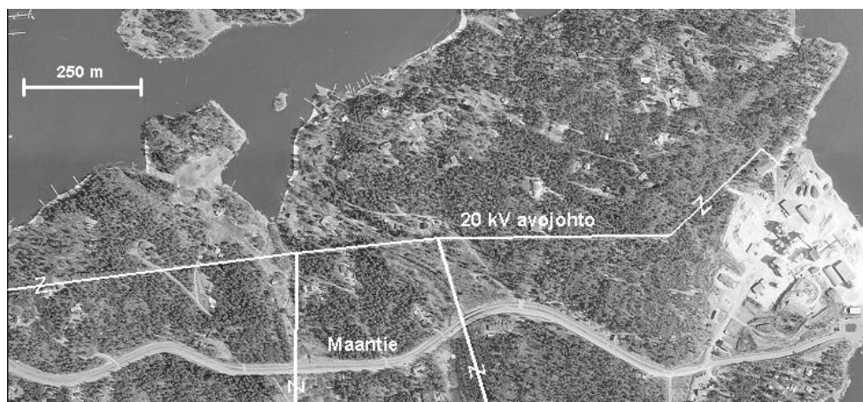
Kuva 5.6. Tyypillinen 20 kV keskijännitejohtoreitti haja-asutusalueella. Johtokatu kulkee metsässä, vaikka lähellä maantien varressa olisi tarjolla suojaisempi reitti.
