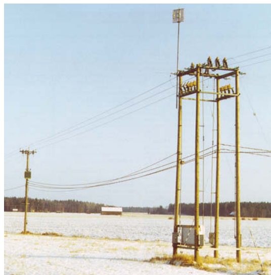
Kuva 5.11. Kauko-ohjattava erotinasema.
