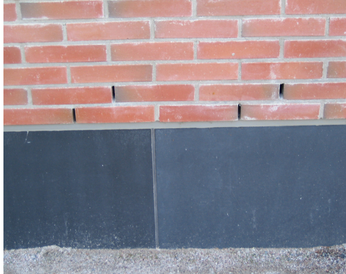
Kuva 9. Avoimet pystysaumamat sokkelin päällä.
