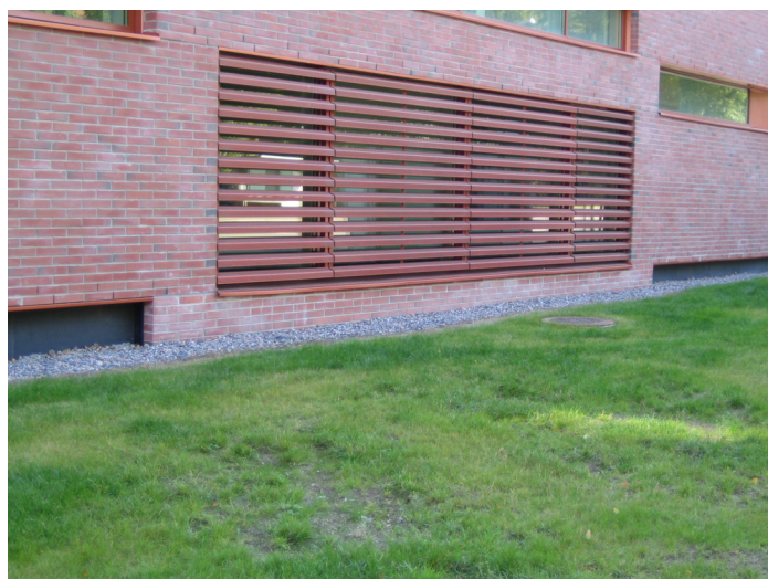
Kuvat 12 ja 13. Digitalon muurauksen ulottuminen maahan asti. Digitalon ikkuna- seiniä.
