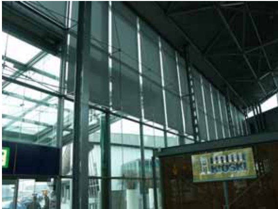
Kuva 7.2. Auringon säteilyn aiheuttaman ylikuumenemisen ja häikäisyn torjuminen sisäpinnalla olevien automaattisten rulla-kaihtimien avulla.
