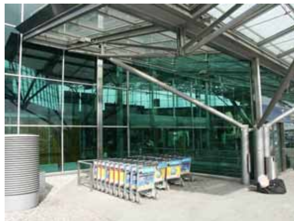
Kuva 7.5. Auringon säteilyn aiheuttaman yllälämpenemisen torjuminen massavärijätyn auringonsuojalasin avulla.
