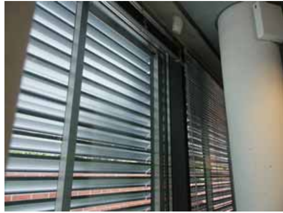
Kuva 7.3. Auringon aiheuttaman häikäisyn torjuminen ulkopuolisten kiinteiden säleiden ja sisäpinnalla olevan sälekaihtimen avulla.
