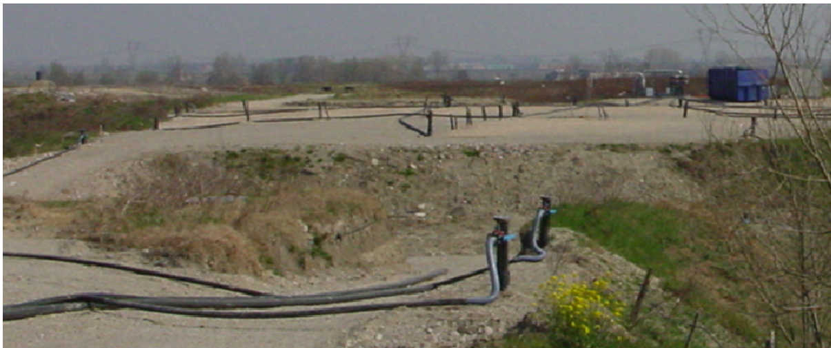
Kuva 30. Modenan vanhan kaatopaikan ilmastuslaitteistoa (Cossu ym. 2003).
