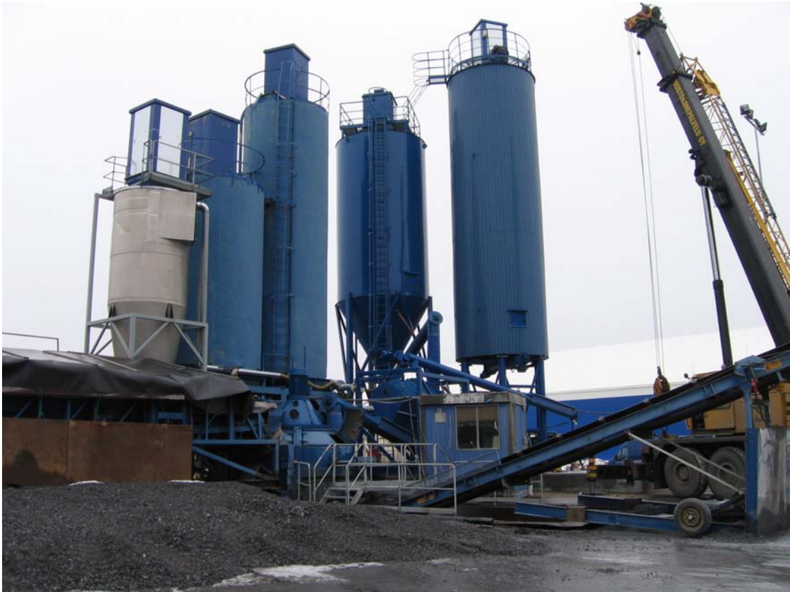
Kuva 1. Rakenteilla oleva pölynkäsittelylaitos.
