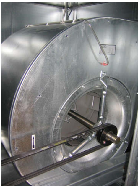
Kuva 2a ja b. Puhallinkohtainen ilmavirran mittausanturointi ja paikallinen osoittava mittari helpottavat käyttöönottoa ja käytön seurantaa.
