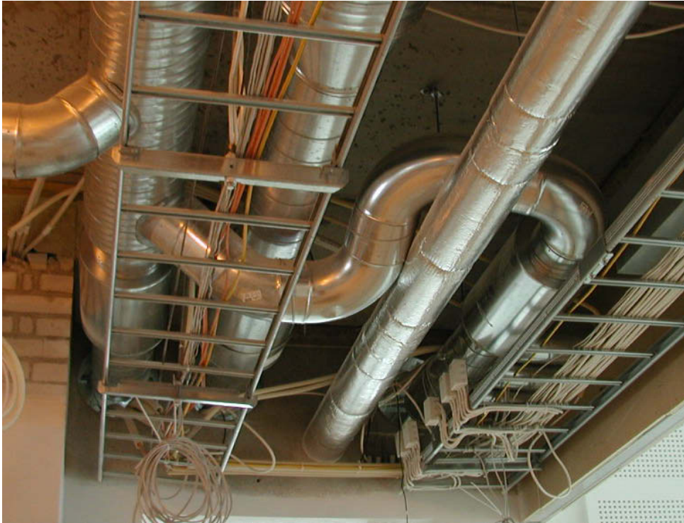
Kuva 1. Suunnitelmasta poikkeavan asennuksen vaikutus äänenkehitykseen, painehäviöön ja mittausepävarmuuteen on arvioitava.
