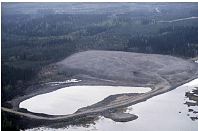
Kuva 1.1. Kangasjärven avolouhos (Kuva: Outokumpu Oyj).
