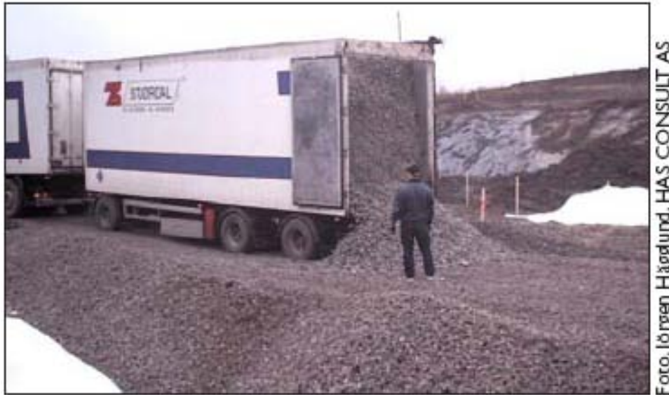
Kuva 12. Kuorman purku tiivistämättömällä vaahtolasimurskepenkalla.
