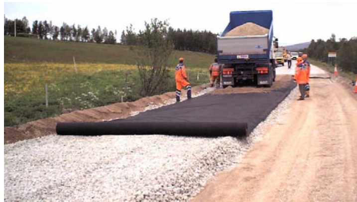
Kuva 14. Vaahtolasieristeen asennus tien routaeristeeksi.
