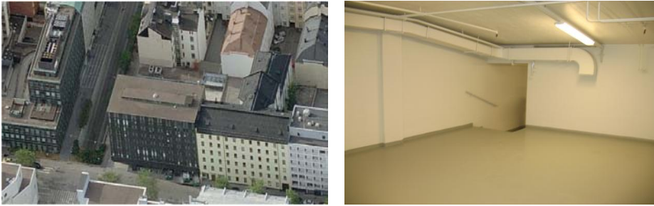
Kuva C5. Malminkatu 28, toimistorakennus ja mittaustila.
