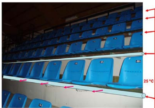
Kuva 27. Katsomon lämmitys penkkien alle asennettavilla ilmastointiputkillä (100 mm).
