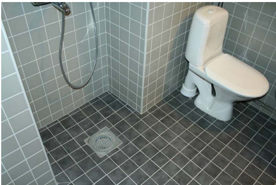
Kuva 29. Valmis kylpyhuone, jossa hormitila on otettu suihkusyvennykseksi.
