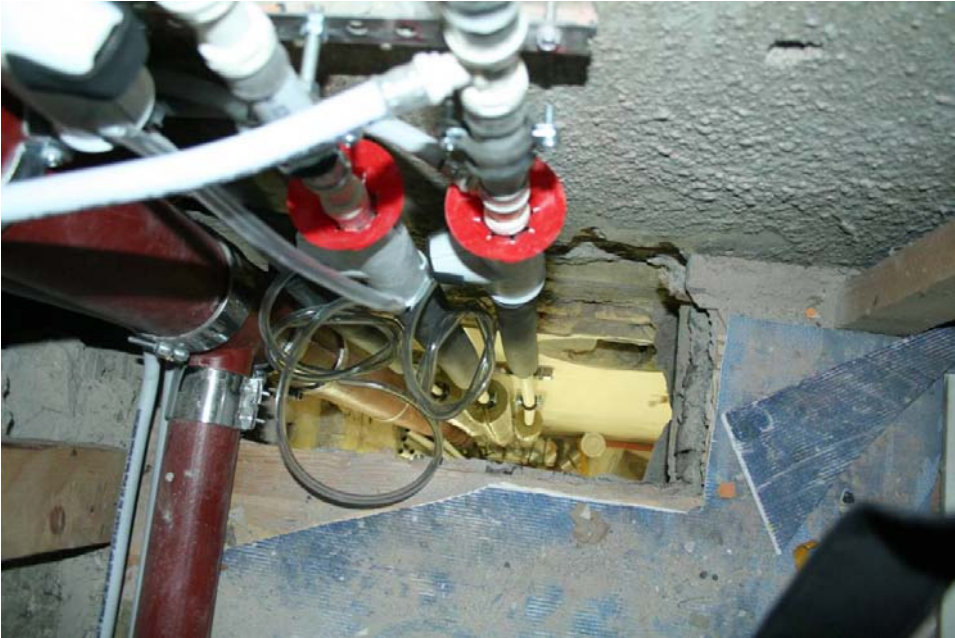
Kuva 18. Kerrosten välisiä läpivientejä.
