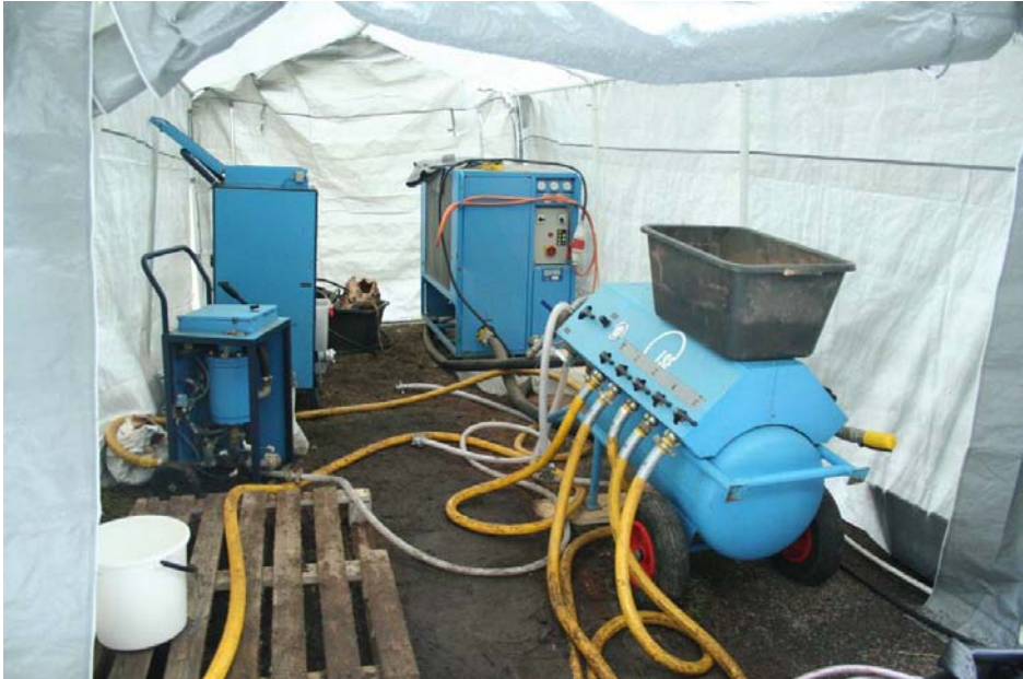
Kuva 25. Epoksinnoituksessa käytettävää laitteistoa.
