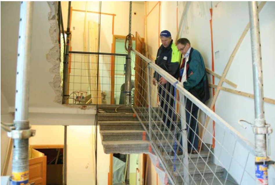
Kuva 16. Putkiremontin aikainen porraskäytävä.
