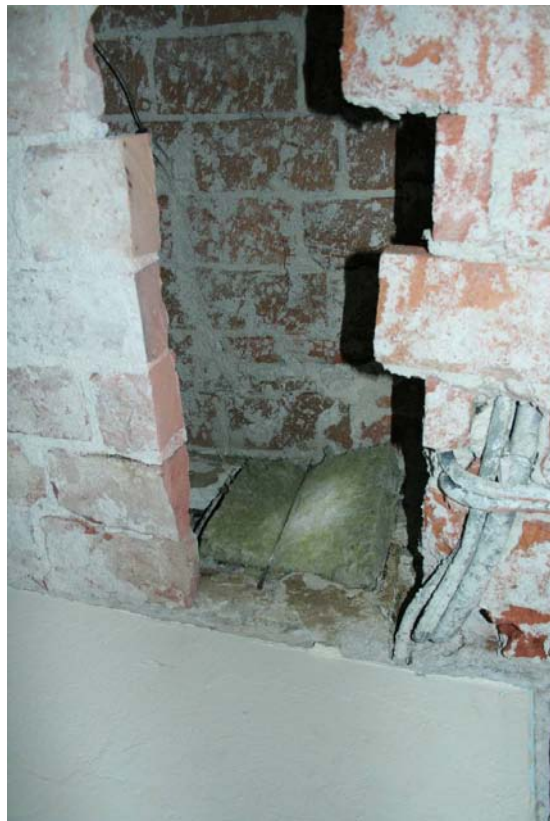
Kuva 28. Kylpyhuoneen seinä purkuvaiheessa. Takana käyttämätön hormitila.
