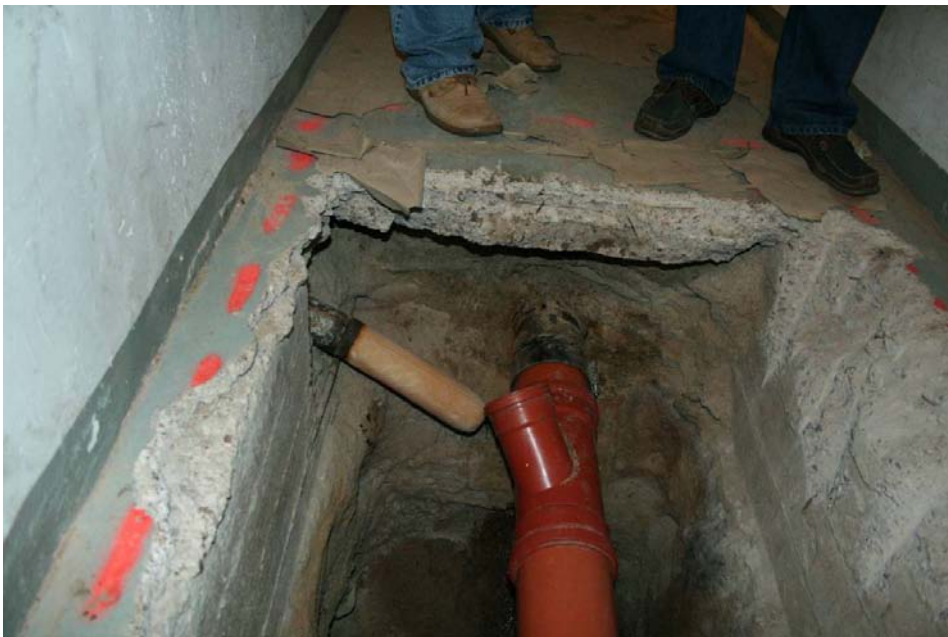
Kuva 24. Pystyviemäriin sukitus valmistumassa.
