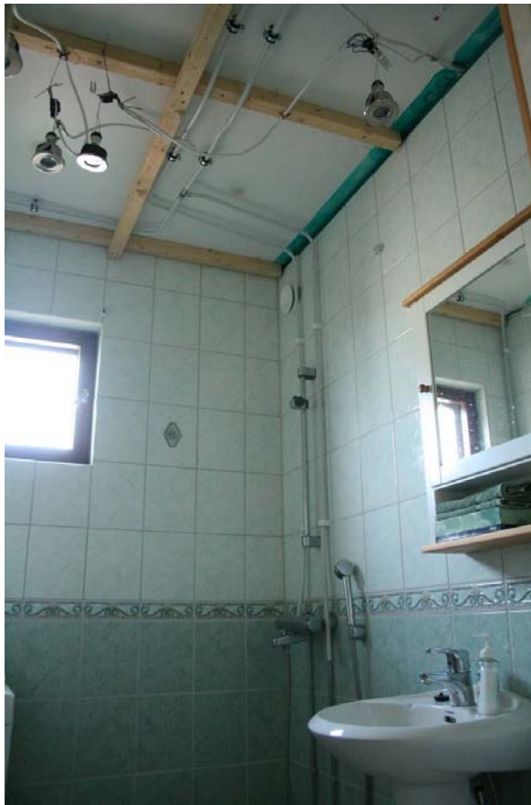
Kuva 23. Valmiit putkivedot kylpyhuoneessa.
