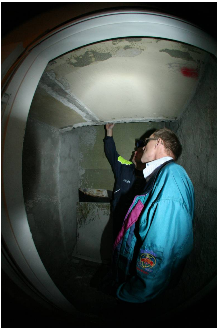
Kuva 19. Eräs tila purkuvaiheessa.
