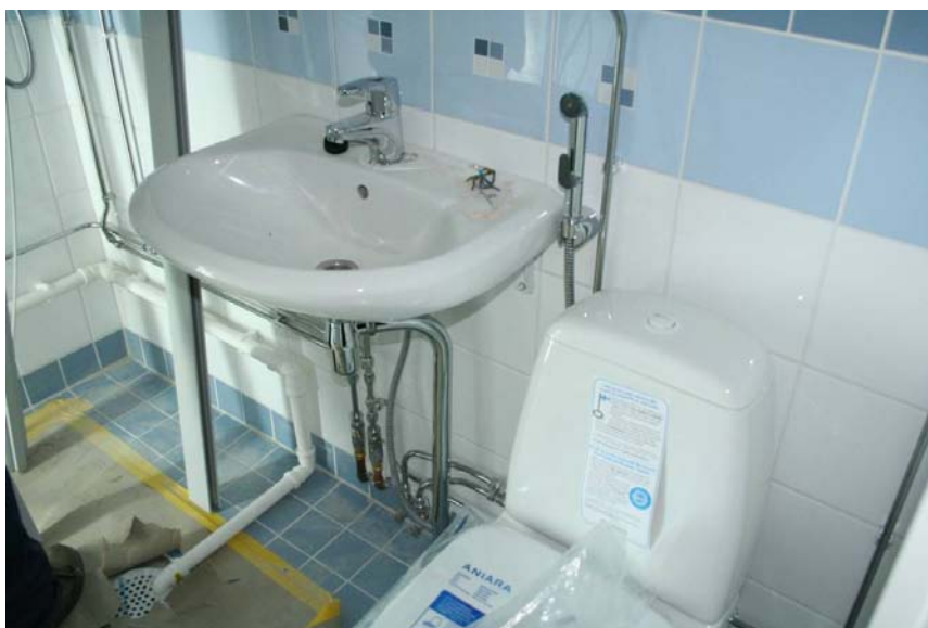
Kuva 27. Valmis kylpyhuone, jossa putket on epoksinnoitettu uusien pintavetojen liitokseen asti.
