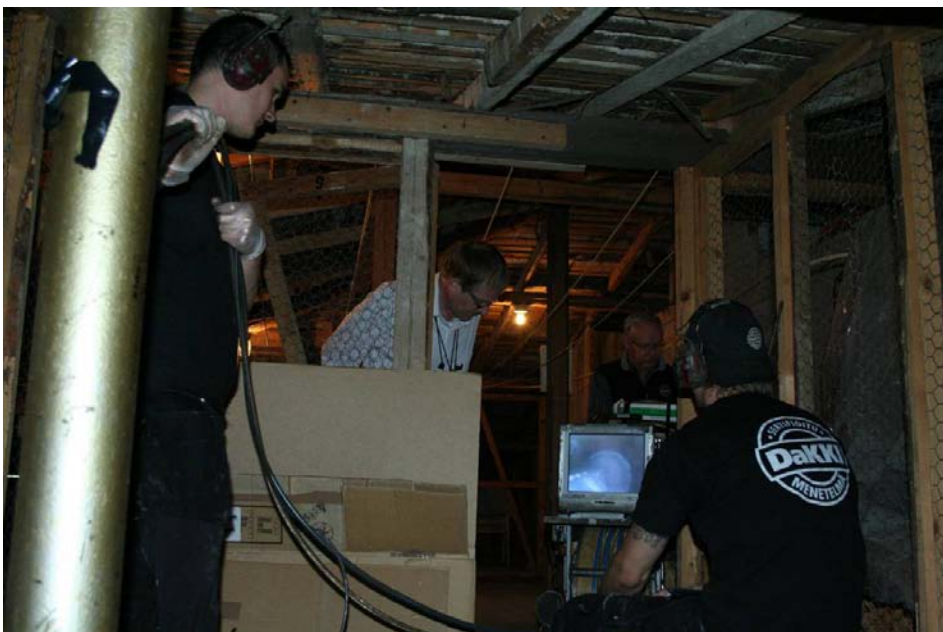
Kuva 35. Pinnoitus käynnissä pystylinjalla. Pinnoituksen kulkua seurataan videokameralla.
