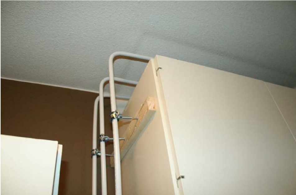
Kuva 21. Putkivetoja huoneiston sisällä.
