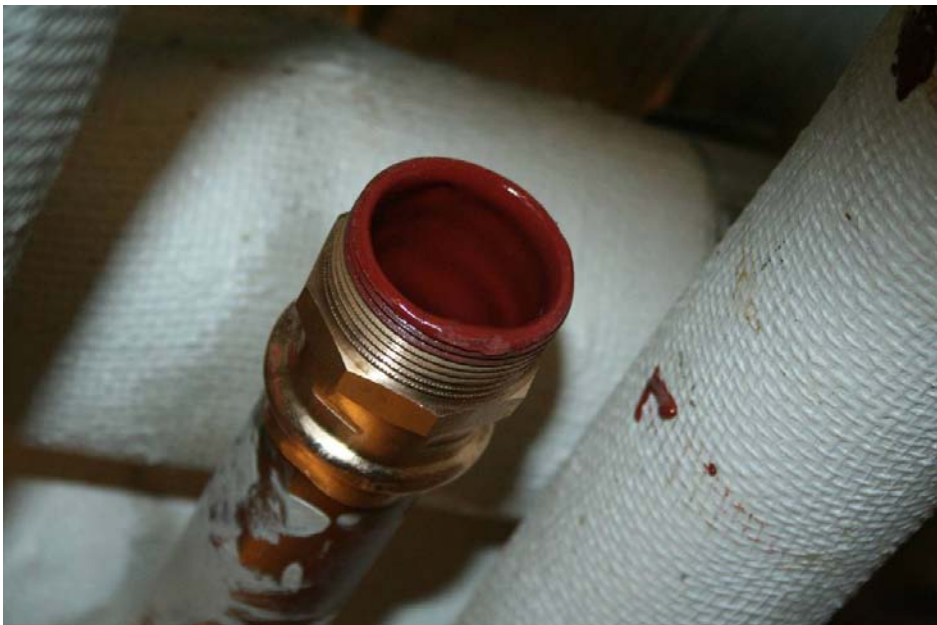
Kuva 26. Epoksinnoitettu putki valmiina.
