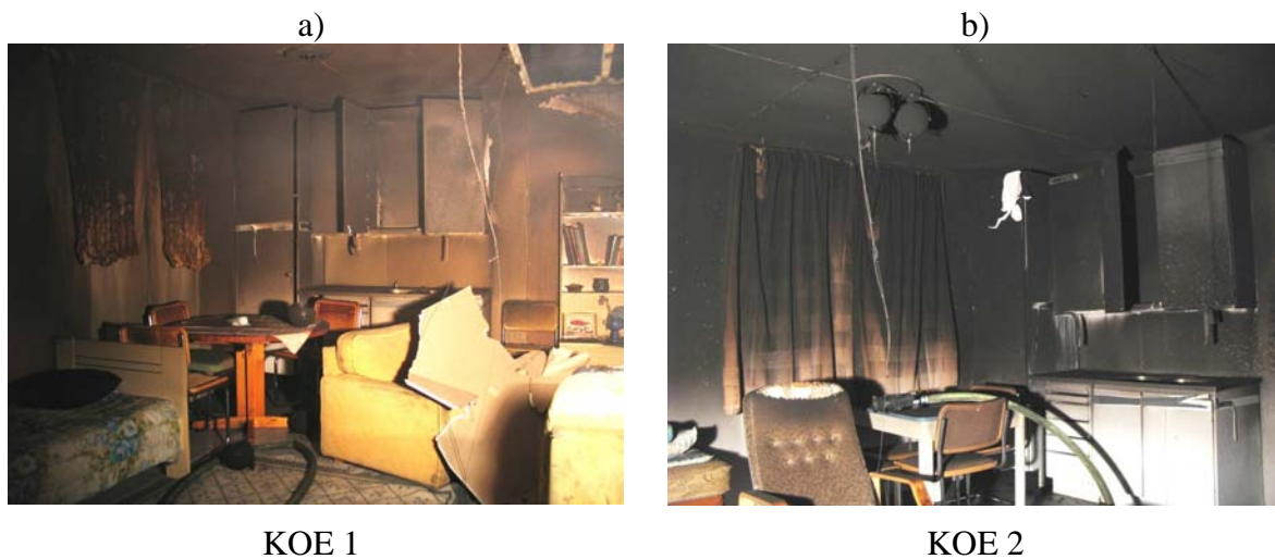
Kuva 17. Näkymä keittiönurkkauksesta kokeen jälkeen a) kokeessa 1 ja b) kokeessa 2.
