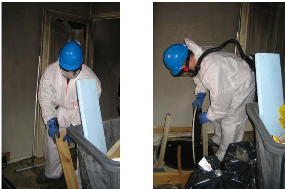
Kuva 29. Valokuvia case A:n palosaneeraustyön raivausvaiheesta.
