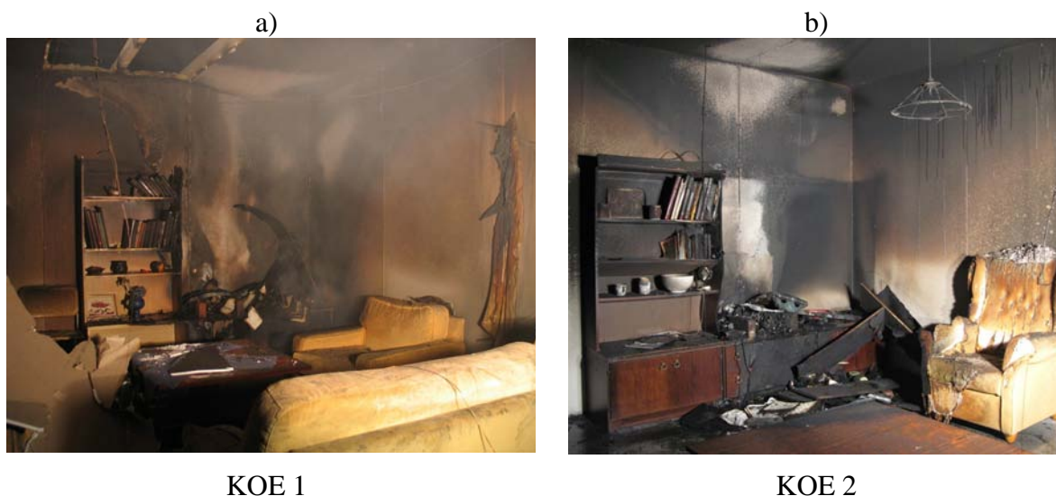
Kuva 18. Näkymä olohuonenuurkkauksesta kokeen jälkeen a) kokeessa 1 ja b) kokeessa 2.
