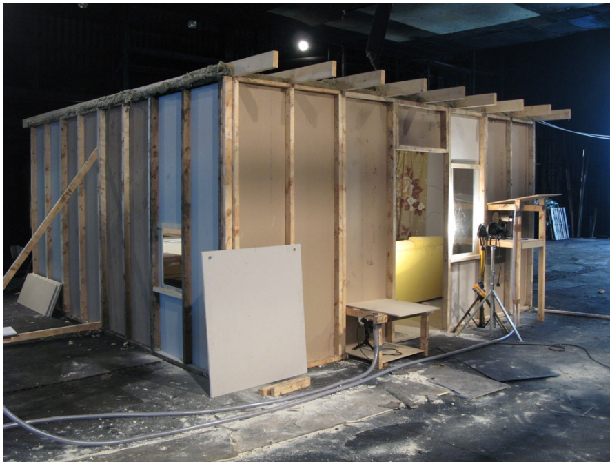
Kuva 2. Valokuva VTT:n sammutushalliin rakennetusta koetilasta.
