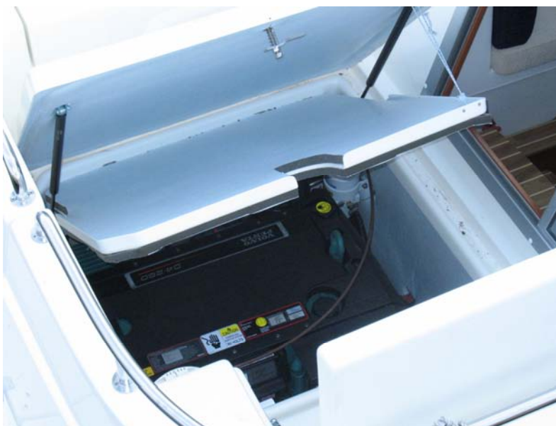
Kuva 45. K1-mod4, moottorin osakotelointi ja moottoritilan kansiluukkujen lisäeristys.
