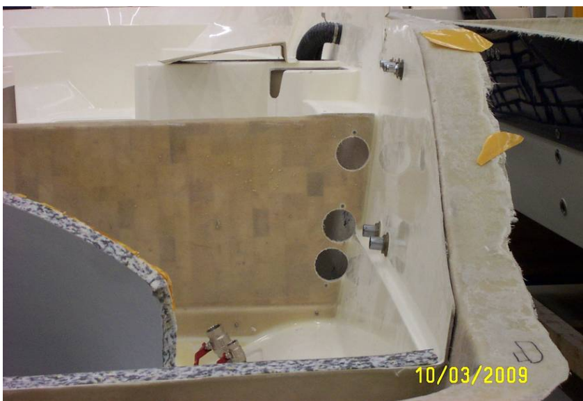
Kuva 42. Erään veneen ohjaus- ja säätökaapeleiden läpivientiin käytetyt reiät ohjaamon ja moottoritilan väliseinässä.
