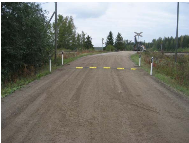
Kuva 10. Paikoillaan oleva hidastetöyssy Riihiojan tasoristeyksessä.
