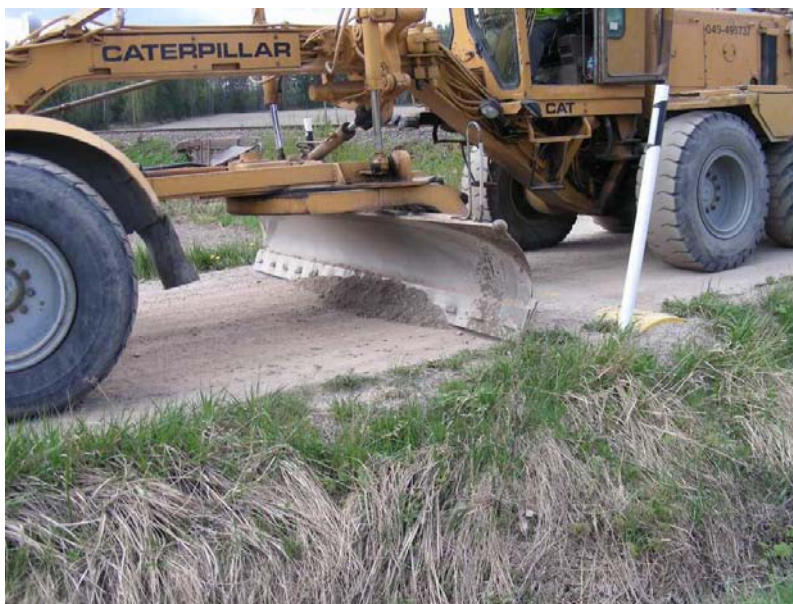
Kuva 11. Hidastetöyssyn lanaaminen uudelleen esiin Ämmälä I:n tasoristeyksessä 20.5.2009.
