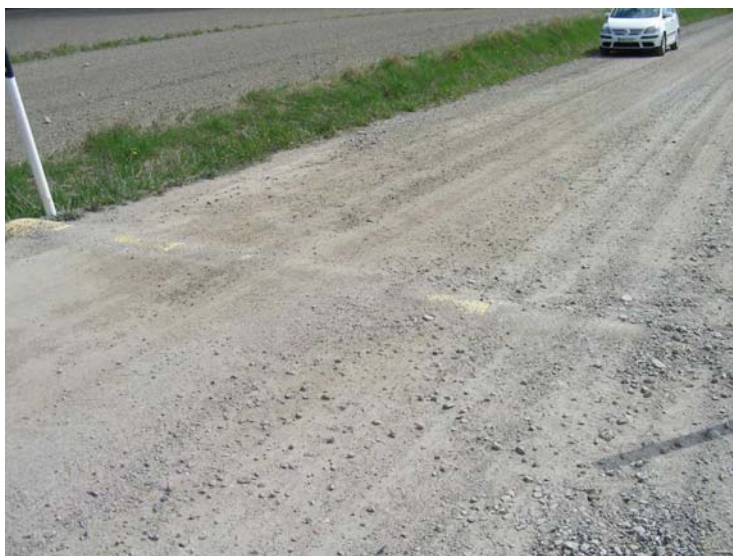
Kuva 26. Ämmälä I:n hidastetöyssi ennen esille ottamista kuvattuna 20.5.2009.
