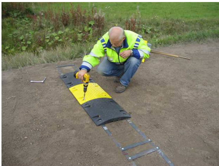
Kuva 8. Kuva töyssyjen asentamisesta.
