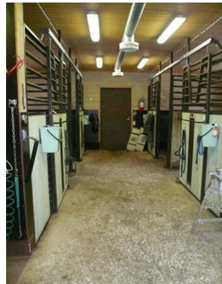
Kuva 100. Hevostalli. Talon seinustalla keskellä ilmanvaihtokoneen ulkoilma- ja jäteilma-aukot. Sisäkuvassa vasemmalla ja oikealla on kaksi karsinaa. Katossa on kaksi tuloilmaventtiiliä.
