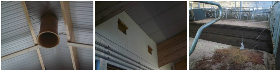
Kuva 39. a) Poistoilmakanava katossa, b) tuloilmaventtiilit seinässä ja c) vetomittaus alapoiston kohdalla.
