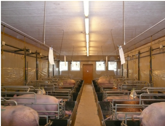
Kuva 91. a) Porsitusosastossa osastoon tuleva ilma ohjataan 1,6 m korkean, käytäväseinästä ulkoseinään ulottuvien muoviseinäkkeiden yli. b) Vetomittauksen tulokset syksyllä perustilanteessa (mittaustilanne 1). Lattiamittaustulokset on ympyröity.
