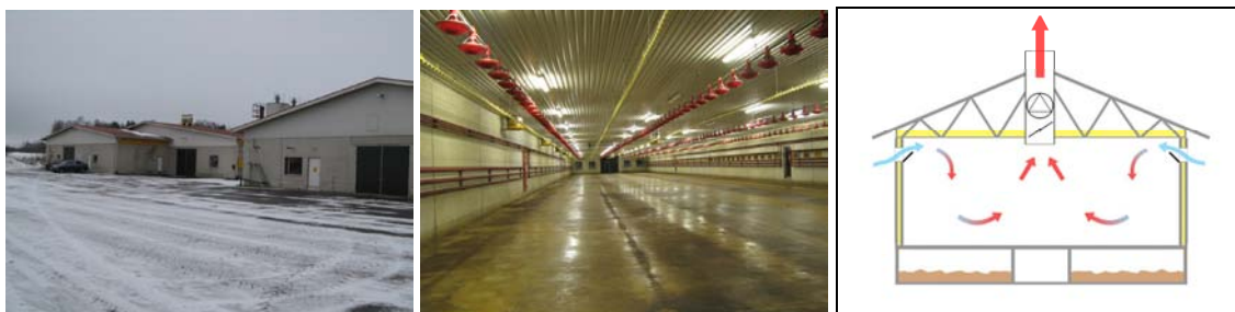
Kuva 95. Broilerikasvattamo, halli 1. Vasemmalla katossa poistoilmanvaihtopuhaltimet (7 kpl), keskellä katossa ilmankierrätyspuhaltimet (4 kpl), takaseinällä kesäajan ilmanvaihdon tehostuspuhaltimet (4 kpl) ja oikealla seinällä ulkoilmaventtiilit (70 kpl).
