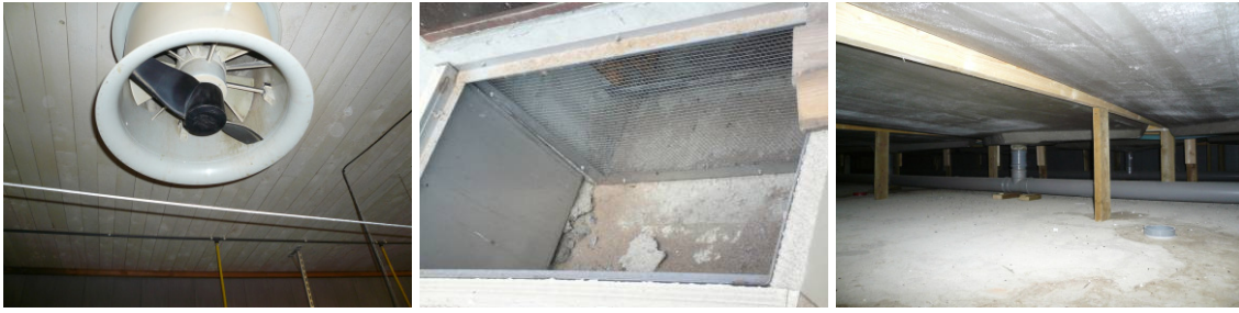
Kuva 73. a) Porsitusosaston poistoilmakanava katossa. Alimmaisena on musta mittapuhallin. b) Ulkoilma-aukko. c) Alapohjan yläreunassa näkyvät lantakaukaloiden pohjat, joista lähtevä putkisto kuljettaa lannan ja virtsan lietesäiliöön.
