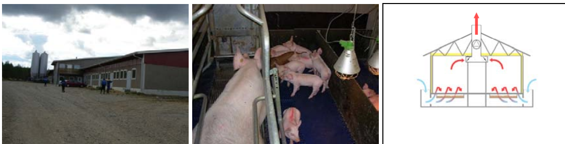
Kuva 84. Porsitussikala, jossa on yli 900 emakkoa. Oikealla ilmanvaihdon periaate.
