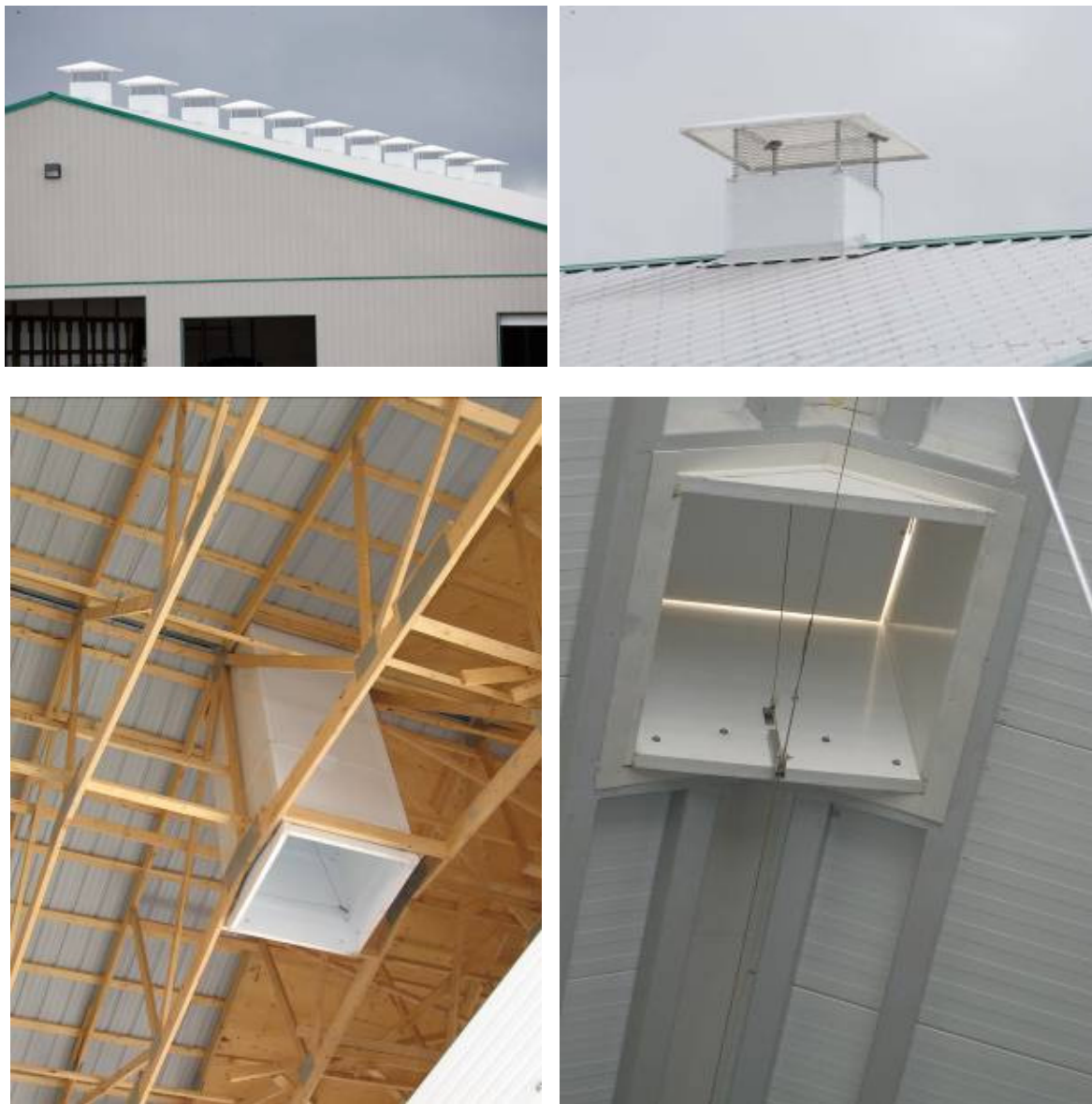
Kuva 7. Esimerkkejä ilmanpoiston ratkaisuista.
