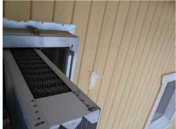
Kuva 101. Lämpöä talteen ottava ilmanvaihtokone (Energent EGP-01). LTO:n kennosto voidaan puhdistaa ulkoa käsin.
