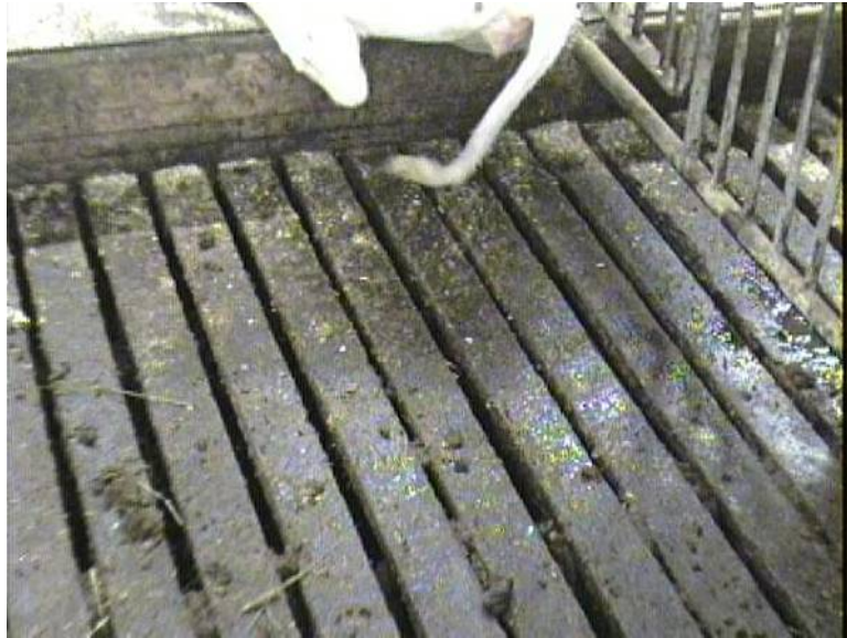
Kuva 45. Ritiälattian lämpötila vaihteli +15,3 °C:sta +10,1 °C:een.
