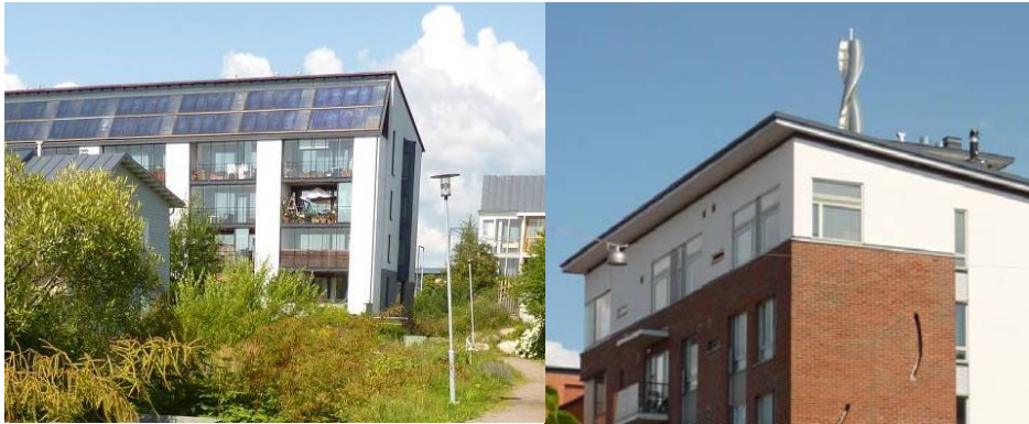
Kuva 51. Esimerkkejä uusiutuvien energialähteiden hyödyntämisteknologioista: aurinkokeräimiä ja tuuliroottori asennettuina kerrostalojen katoille (vasemmalla Helsingin Viikissä ja oikealla Helsingin Arabianrannassa (kuvat Lahti 2009).
