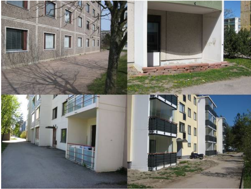
Kuva 34. Peltosaaren maantasokerroksen asunnot kärsivät yksityisyyden puutteesta erityisesti silloin, kun tie sivuaa rakennusta ja ikkunoiden korkeusasema on katselukorkeudella (kuvat Lylykangas 2009).
