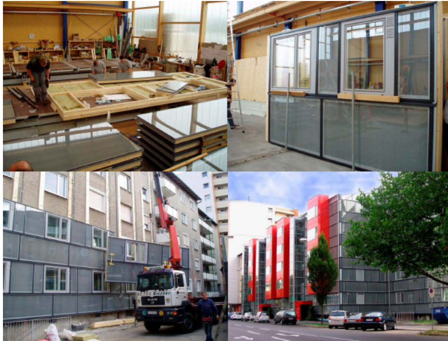
Kuva 31. Esimerkki julkisivujen uudistamisesta ja koko kiinteistön energiatehokkuuden tasokorotuksesta esivalmistetuilla julkisivuelementeillä: 1950-luvun lopulla valmistuneen asuinkerrostalon passiivitalosaneeraus Linzissä, Itävallassa. Elementtiasennus tapahtuu ilman telineitä, ja elementteihin on tehty ikkuna- ja talotekniikka-asennukset tehtaalla (kuvat: Lylykangas).
