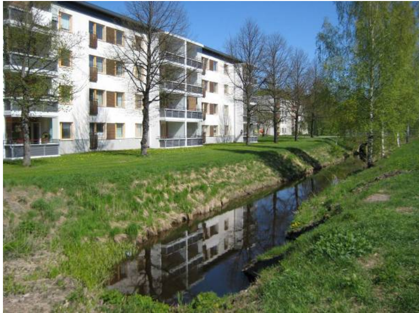
Kuva 43. Peltosaaren eteläosissa rakennuksen laajamittainen korjaus on muuttanut julkisivujen ja asuinympäristön ilmettä suotuisalla tavalla. Parvekkeiden syvyyttä on kasvatettu ja ne on lasitettu. Pieniin asuntoihin on lisätty ranskalainen parveke. Vaalea rappauspinta peittää julkisivujen elementtijaon (kuva Lylykangas 2009).
