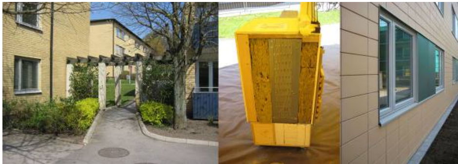
Kuva 37. Ruotsissa Brogården asuinkerrostalojen julkisivukorjauksen varsinaisena syynä oli keltatiilipinnan lohkeilu ja rapautuminen säärasituksessa. Korjauksen energiatehokkuustavoitteeksi asetettiin ruotsalaisen passiivitalon kriteerien saavuttaminen. Julkisivujen käsittelyn tavoitteena oli säilyttää rakennusten ilme ennallaan lisälämmöneristämisestä huolimatta. Parvekejulkisivuilla huoneistoja laajennettiin, ja uusi julkisivu rakennettiin teräsraangoista paikan päällä. Korjatun julkisivun tiililaatta avosaumoinen luo rakennuksille kuitenkin huomattavasti alkuperäistä tiilimuurausta kylmemmän ja teollisemmän ilmeen. Muutos osoittaa, miten suuri merkitys materiaalivalinnoilla on ympäristön kokemisessa (kuvat Lylykangas 2009).
