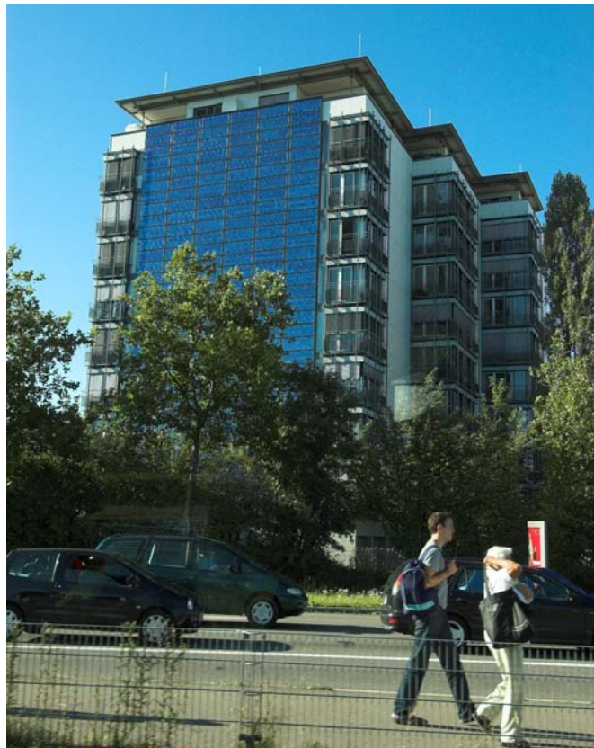
Rakennusten seinustaan kiinnitettiin aurinkopaneeleja.
