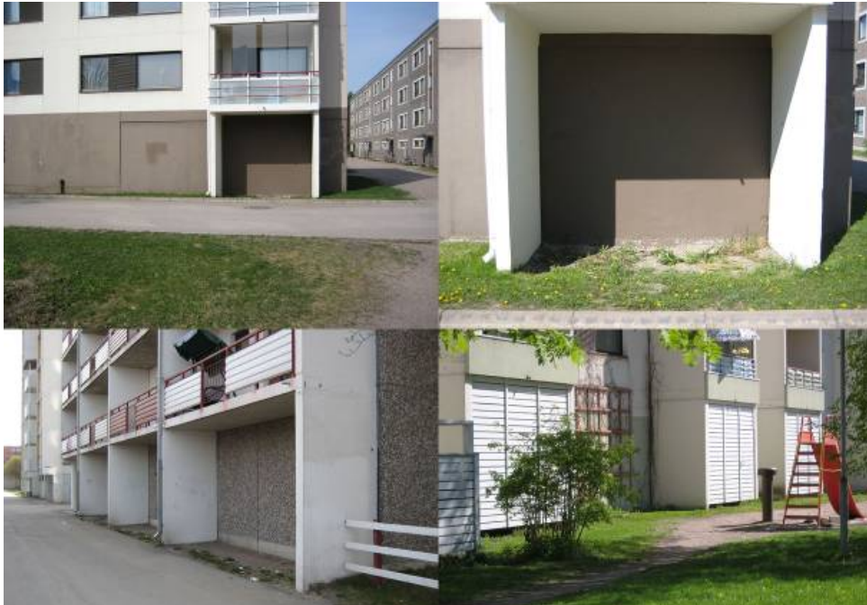
Kuva 36. Katutason julkisivun käsittely on rakennetun ympäristön kokemisen kannalta tärkein osa rakennusten julkisivuarkkitehtuuria. Parvekkeiden toteutustapa on joissakin tapauksissa tuottanut muutenkin ankeaan ja ikkunattomaan katujulkisivuun omalaatuisia syvennyksiä, joilla ei ole käyttötarkoitusta. Kekseliäät asukkaat ovat ottaneet syvennykset varastokäyttöön. Julkisivukäsittelyn ongelmat juontavat kuitenkin 1970-luvun asuinkerrostaloille tyypillisestä suunnitteluratkaisusta, jossa kellaritilojen talojen maantasokerrokseen on sijoitettu ikkunattomat varasto- ja väestönsuojatilat (kuvat Lylykangas 2009).
