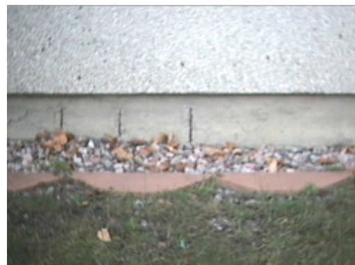
Kuva 16. Ulkoseinän ja perustuksen liittymä muodostaa kauttaaltaan kylmäsilan. Koko liittymärakenne vaatii peruskorjausta (Kiinteistö Oy Riihenpuoli, kuvat Nikkanen 2009).
