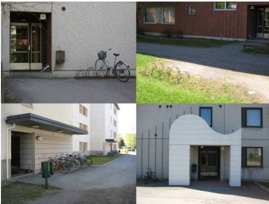
Kuva 35. Asunnon sisäänkäynti on julkisivun tärkeimpiä yksityiskohtia. Alkuperäinen sisäänkäynti tarjoaa äärimmäisen niukan sääsuojan sisäänvedon muodossa. Polkupyöräilijöiden tarpeita tai esteettömyyttä ei ole huomioitu, ja arkkitehtuuri tuskin tukee myönteistä kotiintulon kokemusta. Ongelmaa on pyritty useassa talossa korjaamaan lisäämällä sisäänkäynnin yhteyteen myös polkupyöriä suojaava katos. 1970-luvun arkkitehtuurista voimakkaasti poikkeavat muotoaiheet lisäosissa kertovat muutoksen ja yksilöllisyyden kaipuusta, mutta niillä ei ole välttämättä saavutettu toivottua vaikutusta (kuvat Lylykangas 2009).
