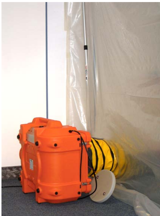
Kuva 4. Alipaineistusjärjestely epäpuhtauksien leviämisen estämiseksi.
