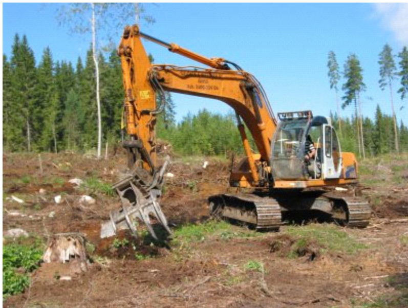
Kuva 25. Kantojen nostoa ja maanmuokkausta kantoharalla (J. Laitila, Metla).
