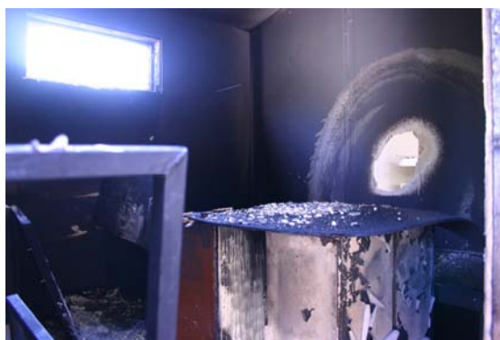
Kuva 34. Cobra-sammutinleikkurin vesisuihkun läpäisemä väliseinä, jossa nähtävillä myös vesisuihkun tuottama kuvio (halkaisija n. 2 m).
