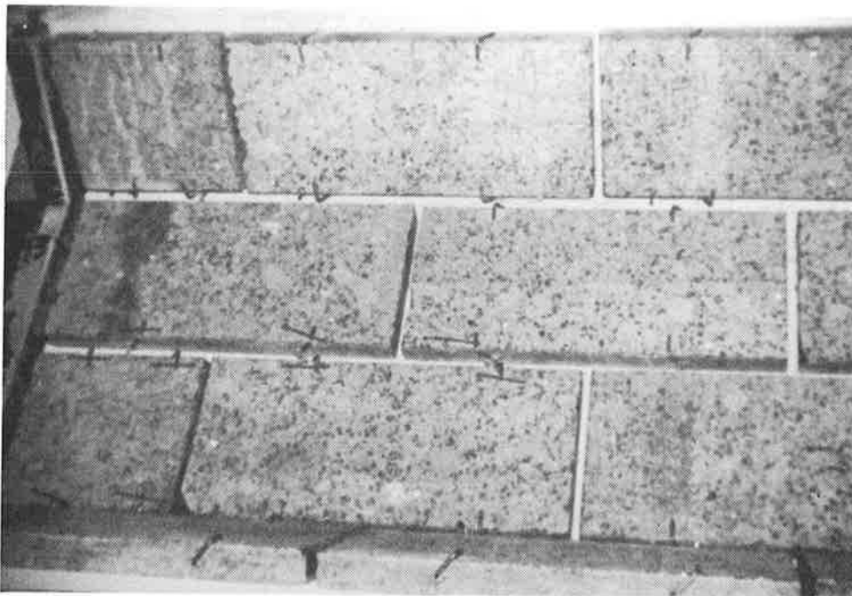
Kuva 68. Luonnokivilaatat ja tartuntakiinnikkeet muottiin asennettuina.
