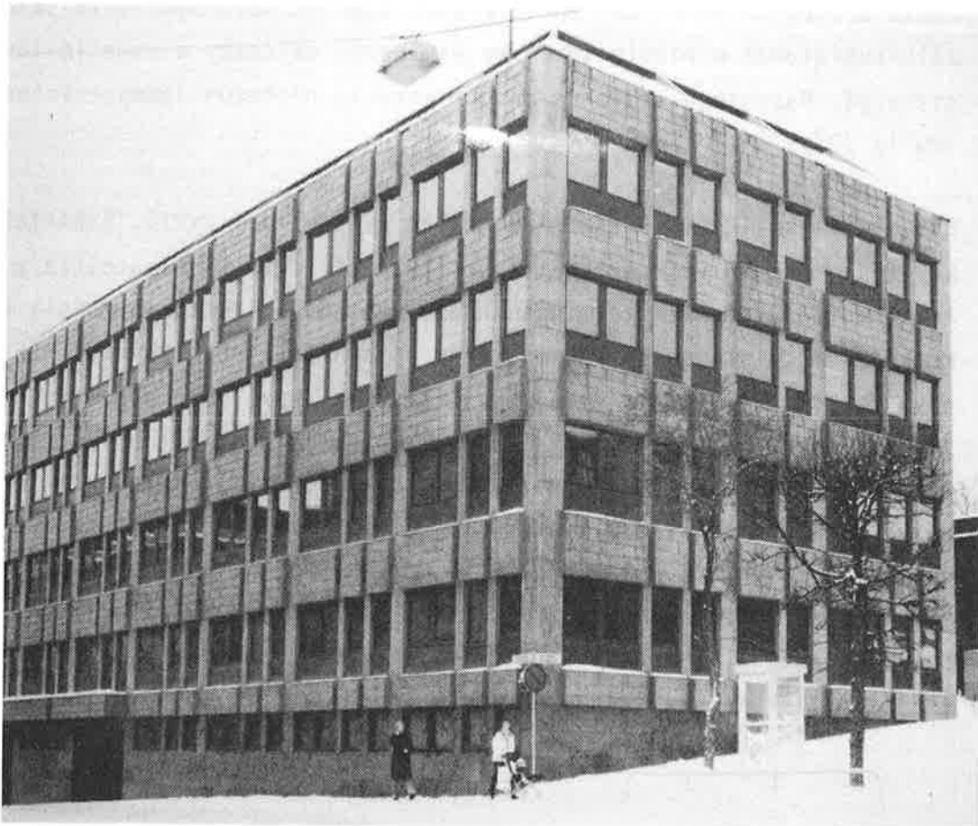
Kuva 8. Kivikartio Oy:n rakentama Sampoyhtiöiden toimitalo Turussa. Kivilaatat kiinnitetty valussa betonisandwichelementin pintaan.
