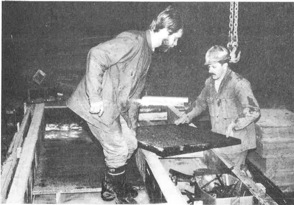
Kuva 50. Kivilaattojen asennus muottiin.
