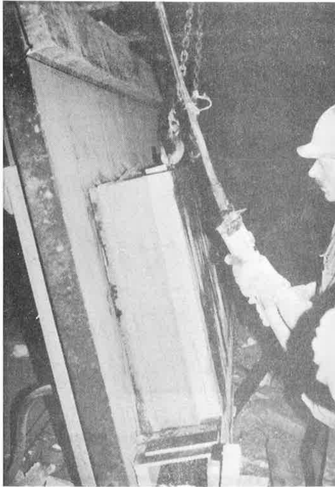
Kuva 57. Koe-elementin nosto muotista. Muotin on oltava mahdollisimman lähellä pystyasentoa, jotta elementin luonnonkivikuoren alareuna ei vaurioidu nostovaiheessa.
