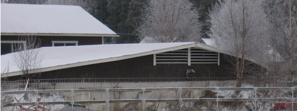
Kuva 6.2. Mittauskohteena käytetty katettu lietelantala. Huomaa tuuletusaukot päädyssä.
