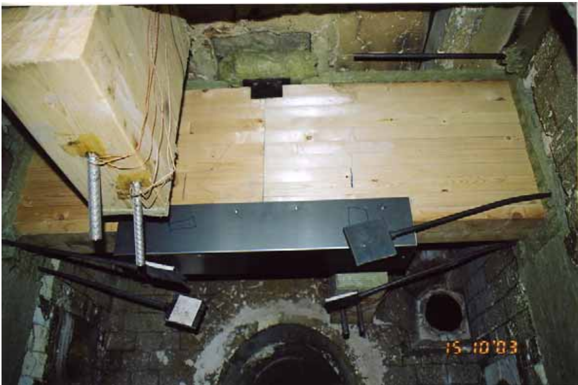
Kuva B.29. Liitoksen suojauskotelo.
