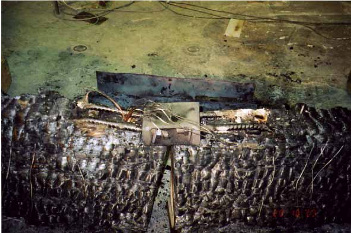
Kuva B.34. Liitos aukaistuna polttokokeen jälkeen.
