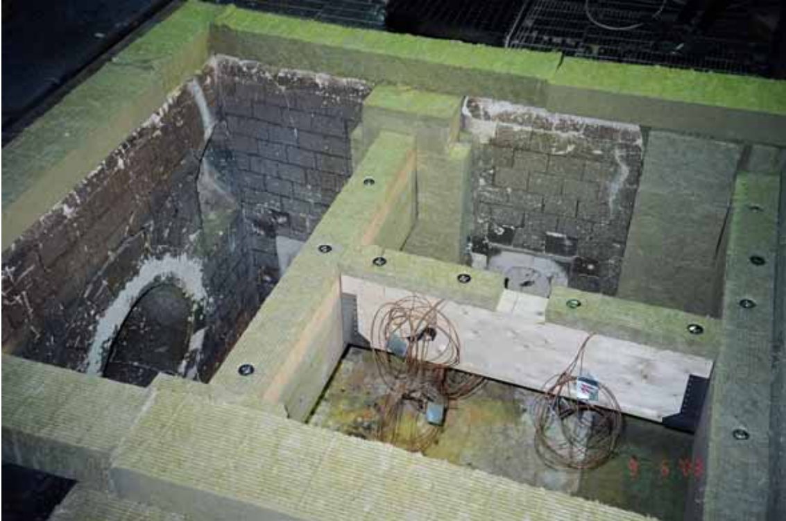
Kuva A.35. Palkkikenkäliitos uuniin asennettuna ennen koetta. Kuva ylhäältä.
