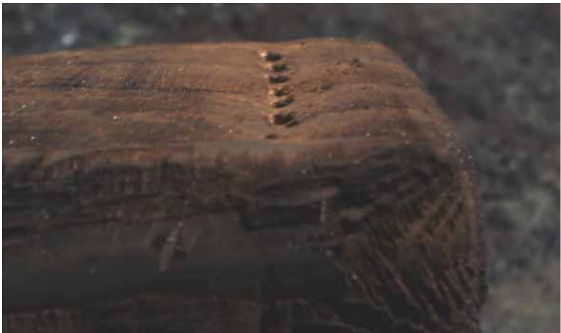
Kuva A.58. Poikkipalkin naulojen kohta kokeen jälkeen, kun hiiltymä poistettu.
