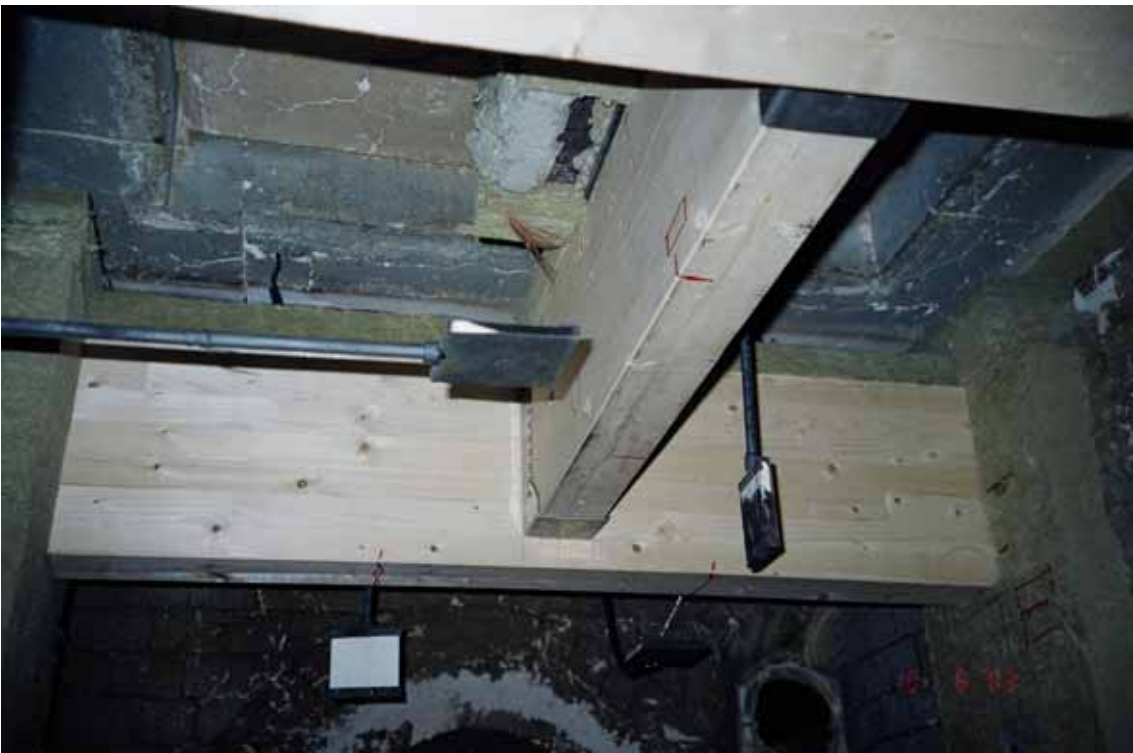
Kuva A.36. Palkkikenkäliitos uuniin asennettuna ennen koetta
